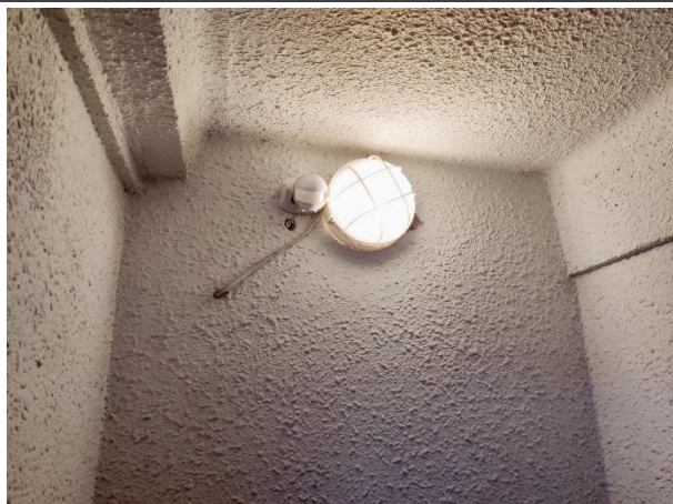
Attēls Nr. 200 Vējveros uzstādīts sienas apgaismojums ar kustību sensoru
