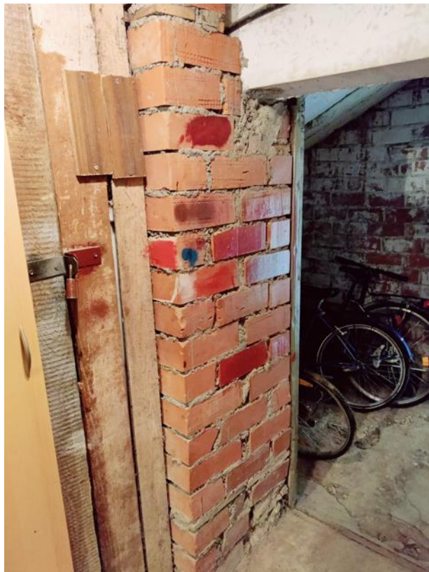
Attēls Nr. 56 Veikti zemas kvalitātes mūrēšanas darbi
