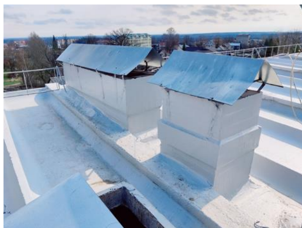
Attēls Nr. 127 Dabīgās ventilācijas izvadkanāls uz ēkas jumta. Uzstādītas skārda nasegcepures
