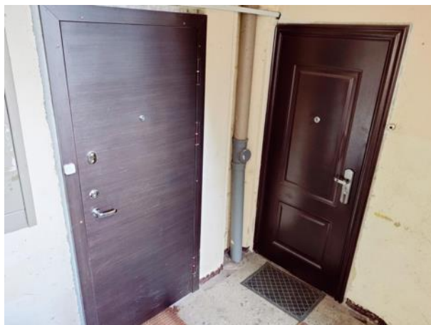
Attēls Nr. 115 Dzīvokļiem uzstādītas dažādu stilu un materiālu ārdurvis, bet tās ir funkcionālā darba kārtībā un apmierinošā stāvoklī
