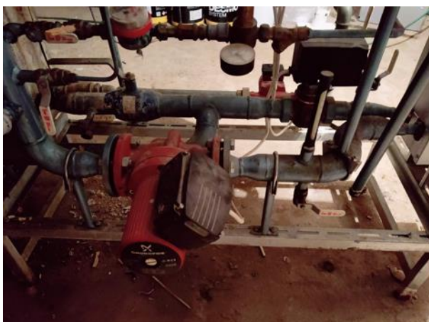
Attēls Nr. 165 Ventīļi, manometri, ūdens patēriņa skaitītājs un citas komponentes
