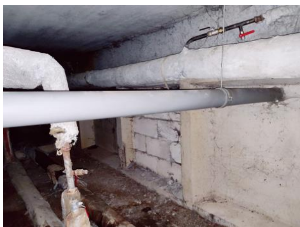
Attēls Nr. 152 Uzstādītas PVC caurules. Blakus izvietotas ūdens caurules ar vēsturisko izolāciju
