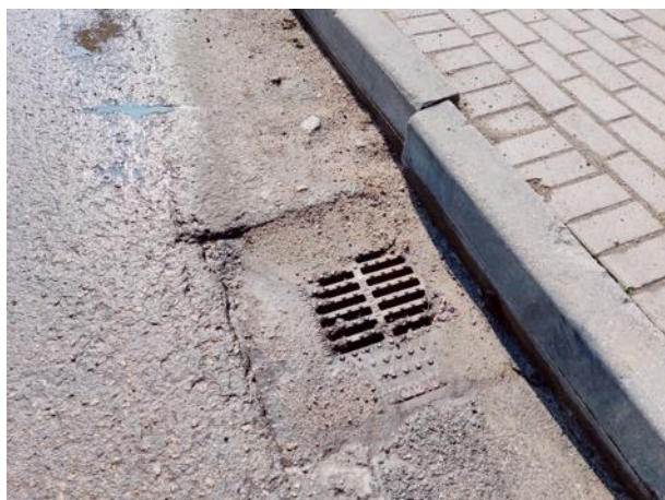
Attēls Nr. 10 Lietusūdens kanalizācija asfaltbetona ceļa segumā
