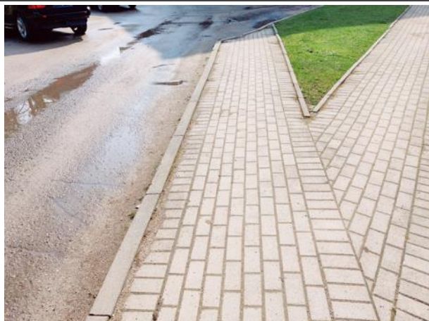
Attēls Nr. 8 Betona bruģa ietves kopskats ēkas priekšā. Kopumā tehniski apmierinošā stāvoklī
