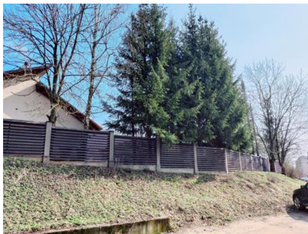
Attēls Nr. 30 Koka dēlīšu žogs ar dzelzsbetona stabiem norobežo dzīvojamo ēkas teritoriju no privātīpašuma
