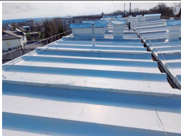
Attēls Nr. 80 Jumta saliekamā dzelzsbetona pārseguma paneļu kopskats. Ir uzklāts jumta hidroizolējošs seguma materiāls. Svaigi krāsota jumta plakne, nomainīti visi skārda elementi
