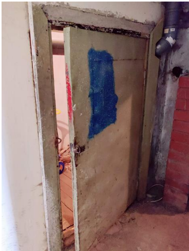
Attēls Nr. 112 Metāla durvis pagrabā, morāli novecojušas, mehāniski bojātas. Rekomendējam veikt nomaiņu
