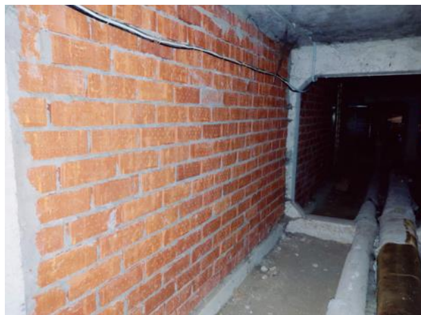
Attēls Nr. 59 Ķieģeļu mūra pašnesošās sienas. Nozīmīgas plaisas vai kādi citi defekti netika konstatēti
