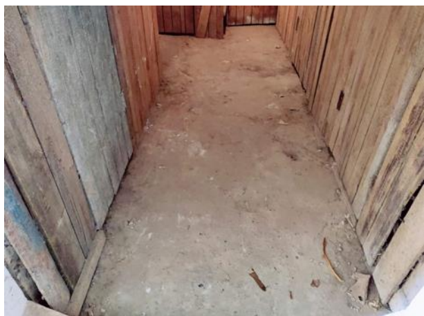
Attēls Nr. 102 Eksponētas betona klona grīdas kopskats pagrabstāvā
