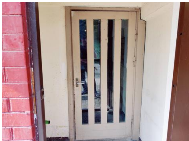
Attēls Nr. 114 Koplietošanas kāpņu telpās ir saglabājušās vecās koka konstrukcijas iekšdurvis. Tās ir morāli novecojušas un nav energoefektīvas
