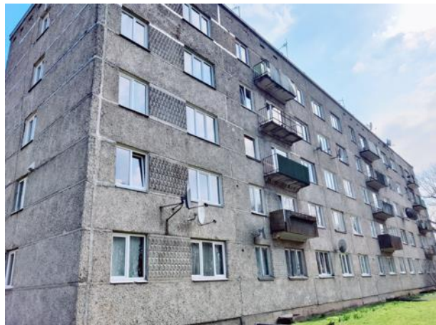
Attēls Nr. 146 Lokāli atjaunotas paneļu šuvju vietas. Kopskats uz iekšpagalma fasādi
