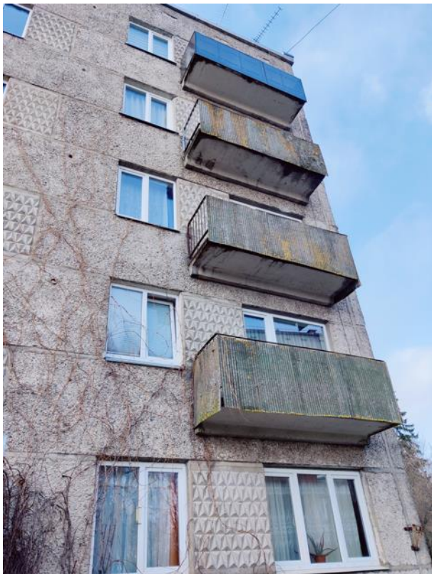
Attēls Nr. 87 Balkonu kopskats, lielākajai daļai kopš ēkas būvēšanas laikiem saglabājušās metāla margas un vēsturiskā viļņoto lokšņu apdare
