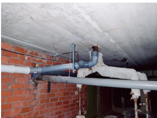
Attēls Nr. 151 Uzstādītas PVC caurules. Blakus izvietotas ūdens caurules ar vēsturisko izolāciju
