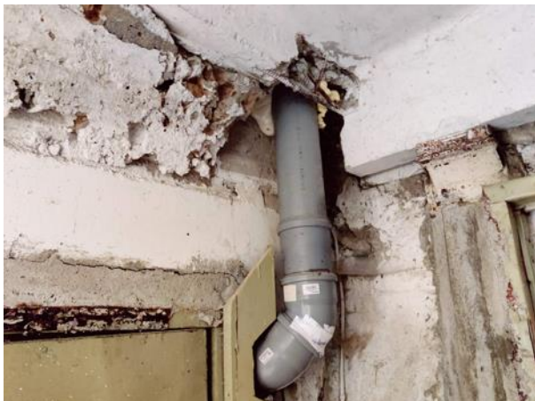
Attēls Nr. 149 Lokāli nomainītas PVC lietusskanalizācijas caurules
