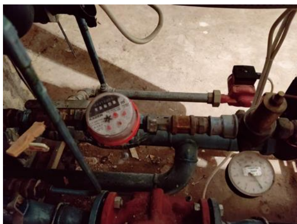
Attēls Nr. 166 Ventīļi, manometri, ūdens patēriņa skaitītājs un citas komponentes
