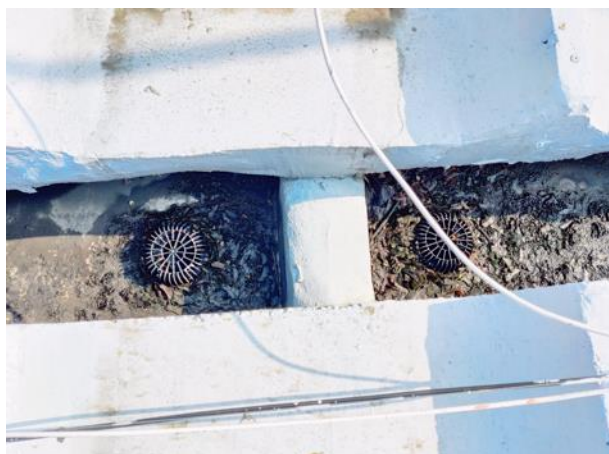
Attēls Nr. 81 Iekšējā lietussūdens novadsistēma. Aizaugušas notekas. Nepieciešams veikt tīrīšanu. Nepieciešams nomainīt grūžu ķērājus
