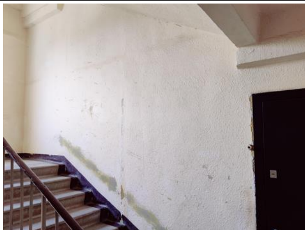
Attēls Nr. 47 Kāpņu telpas nesošās šķērssienas kopskats
