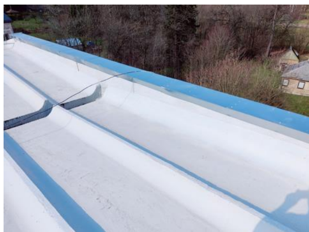
Attēls Nr. 78 Skārda parapets labā stāvoklī
