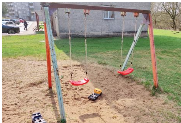
Attēls Nr. 15 Šūpoles, rekomendējam atjaunot aizsargkrāsojumu metāla konstrukcijām
