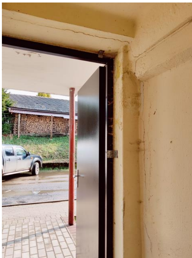
Attēls Nr. 50 Plaisa pārsedzē, kas tālāk aiziet vertikāli pa sienu uz leju. Vizuāla rakstura, eksploatācijas draudus nerada
