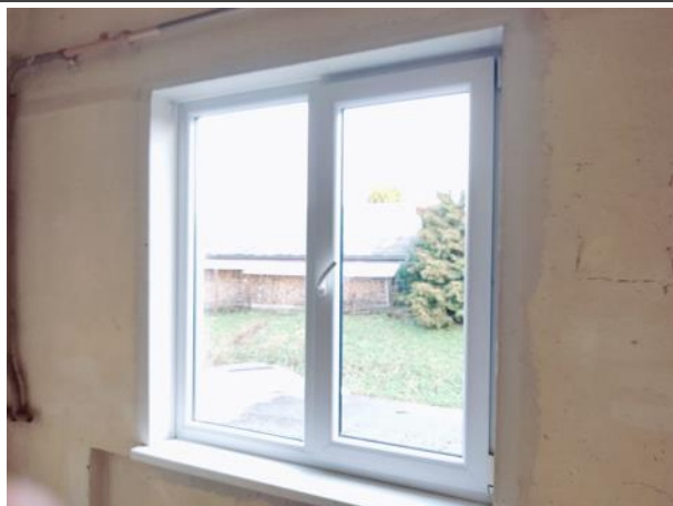
Attēls Nr. 117 Koplietošanas kāpņu telpās 2014.gadā uzstādīti PVC konstrukcijas logi
