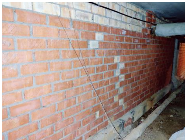
Attēls Nr. 58 Ķieģeļu mūra pašnesošās sienas. Nozīmīgas plaisas vai kādi citi defekti netika konstatēti
