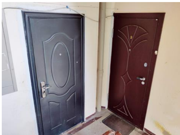
Attēls Nr. 120 Dzīvokļiem uzstādītas dažādu stilu un materiālu ārdurvis, bet tās ir funkcionālā darba kārtībā un apmierinošā stāvoklī
