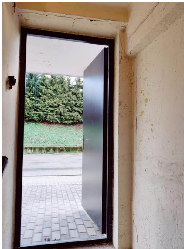
Attēls Nr. 49 Plaisa pārsedzē, kas tālāk aiziet vertikāli pa sienu uz leju. Vizuāla rakstura, eksploatācijas draudus nerada
