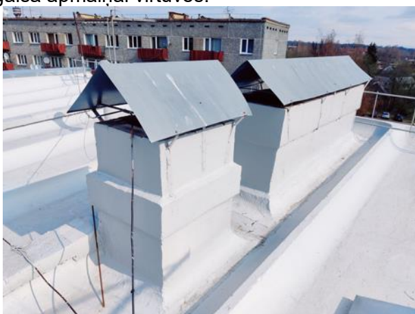
Attēls Nr. 126 Dabīgās ventilācijas izvadkanāls uz ēkas jumta. Uzstādītas skārda nasegcepures
