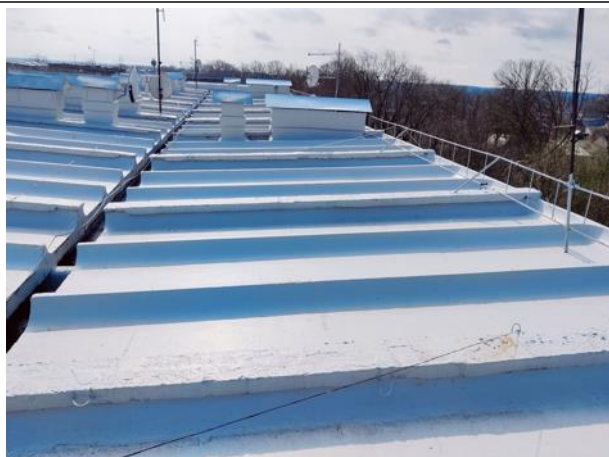
Attēls Nr. 79 Jumta saliekamā dzelzsbetona pārseguma paneļu kopskats. Ir uzklāts jumta hidroizolējošs seguma materiāls. Svaigi krāsota jumta plakne, nomainīti visi skārda elementi
