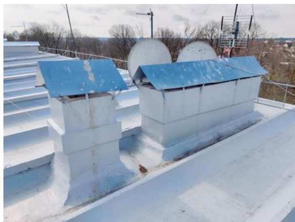
Attēls Nr. 129 Dabīgās ventilācijas izvadkanāls uz ēkas jumta. Uzstādītas skārda nasegcepures
