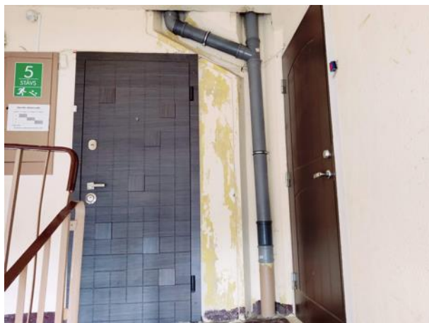
Attēls Nr. 121 Dzīvokļiem uzstādītas dažādu stilu un materiālu ārdurvis, bet tās ir funkcionālā darba kārtībā un apmierinošā stāvoklī
