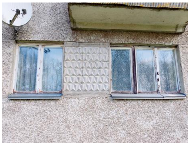
Attēls Nr. 118 Koka logi – rekomendējam veikt nomaiņu uz mūsdienīgiem PVC logiem
