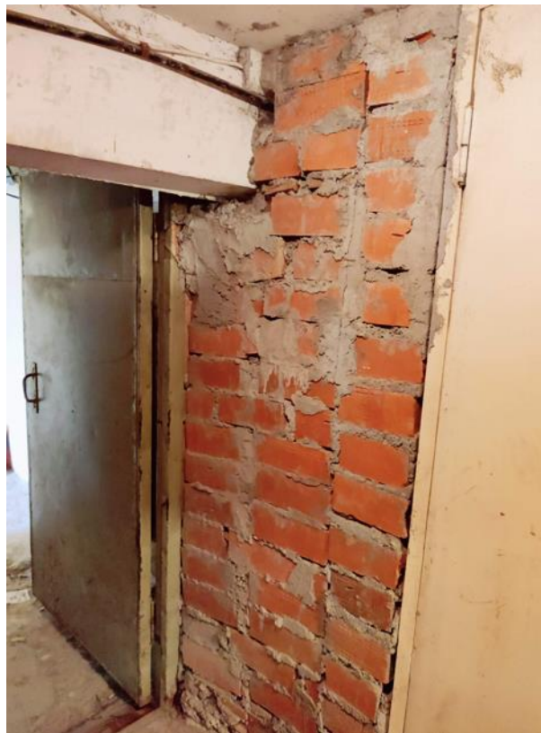
Attēls Nr. 57 Veikti zemas kvalitātes mūrēšanas darbi
