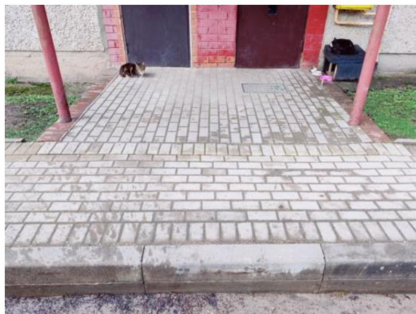
Attēls Nr. 5 Bruģēti laukumiņi pie kāpņu telpas ieejām, bruģēti celiņi gar dzīvojamo ēku. Kopumā tehniski apmierinošā stāvoklī
