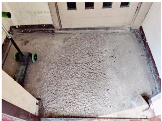
Attēls Nr. 104 Grīda vējtverī
