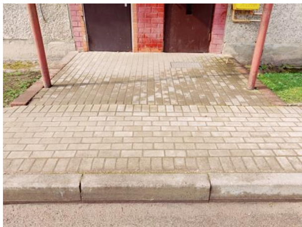
Attēls Nr. 4 Bruģēti laukumiņi pie kāpņu telpas ieejām, bruģēti celiņi gar dzīvojamo ēku. Kopumā tehniski apmierinošā stāvoklī
