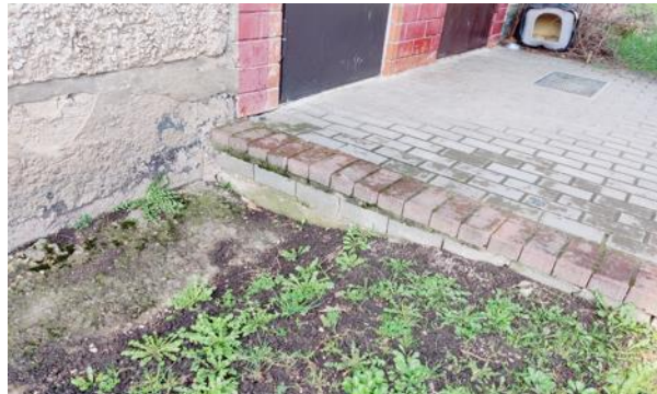
Attēls Nr. 38 Ēkas apmale atrodas zemāk par zālienu, kas veicina lietussūdens sakrāšanos un tecēšanu uz pamatiem. Ēkas apmale jāveido
