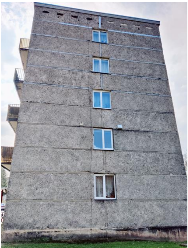
Attēls Nr. 147 Paneļu šuvju hermetizācija ir atjaunota 4.-5. stāvu līmenim
