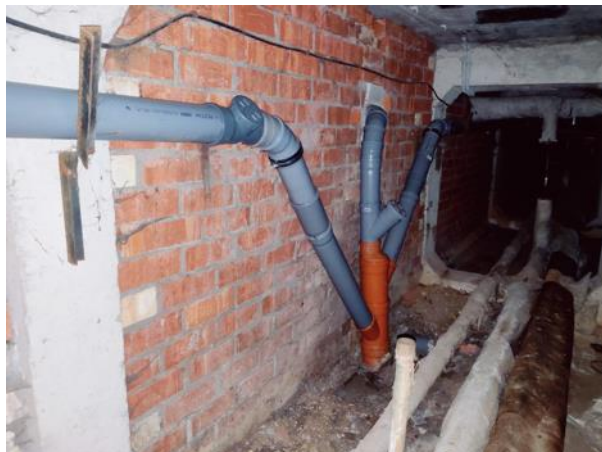
Attēls Nr. 150 Uzstādītas PVC caurules. Pa grīdas daļu izvietotas ūdens caurules ar vēsturisko izolāciju
