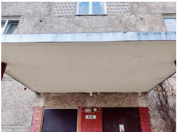
Attēls Nr. 85 Dzelzsbetona plātnes jumtiņa kopskats no apakšpuses
