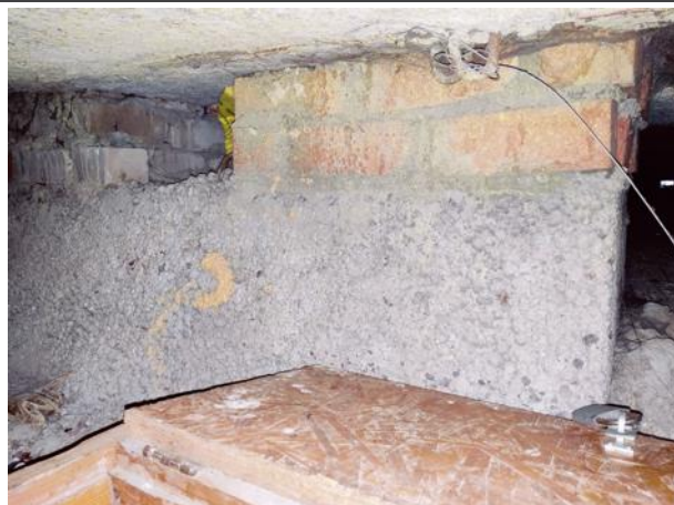
Attēls Nr. 74 Pārseguma plātnei izbūvēti stabveida / lentveida pamati no ķieģeļiem un keramzīta blokiem
