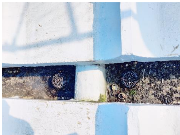
Attēls Nr. 76 Iekšējā lietussūdens novadsistēma. Aizaugušas notekas. Nepieciešams veikt tīrīšanu. Nepieciešams nomainīt grūžu ķērājus
