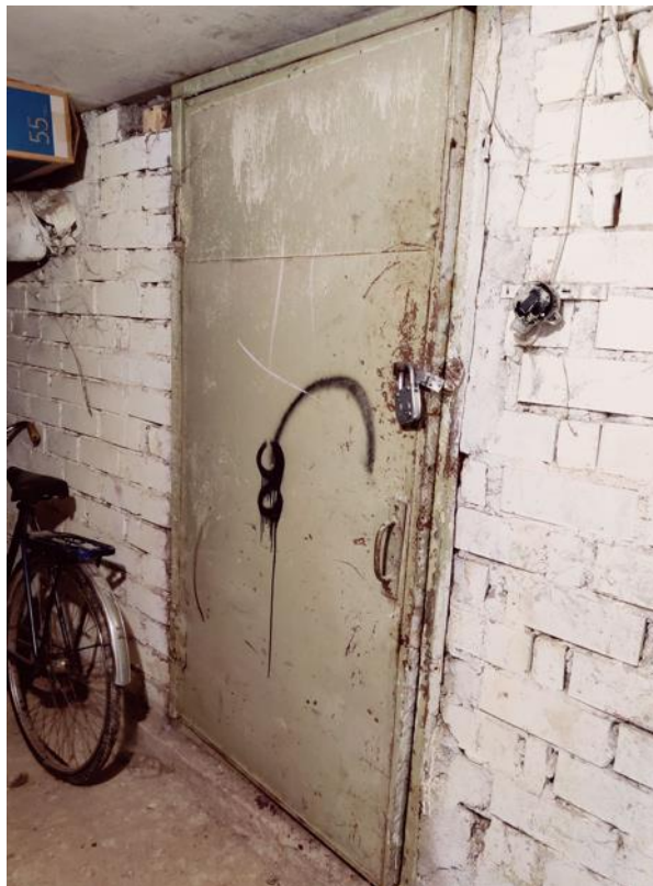
Attēls Nr. 113 Metāla durvis pagrabā, morāli novecojušas, mehāniski bojātas. Rekomendējam veikt nomaiņu
