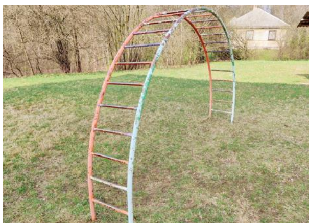
Attēls Nr. 16 Rāpeļi, rekomendējam atjaunot aizsargkrāsojumu metāla konstrukcijām
