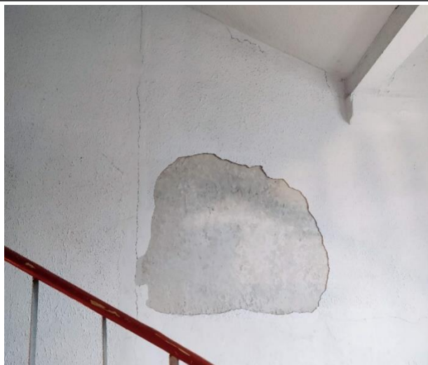
Attēls Nr. 151 Nodrupis liels apmetuma gabals no sienas, plaisas paneļu savienojumu vietās
