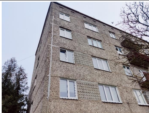
Attēls Nr. 159 Skats uz iekšpagalma fasādes 3.kāpņu telpas zonu
