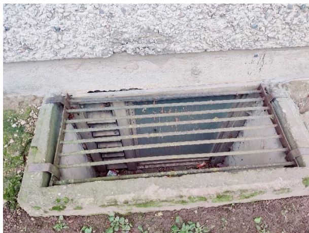
Attēls Nr. 136 Pagrabam saglabājušies vecie koka konstrukcijas logi. Tie nav energoefektīvi
