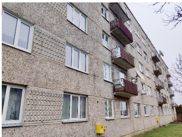
Attēls Nr. 160 Iekšpagalma fasādes kopskats
