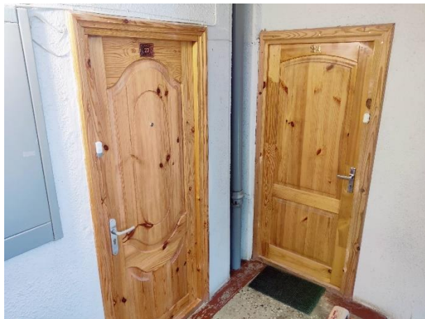
Attēls Nr. 134 Dzīvokļiem uzstādītas dažādu stilu un materiālu ārdurvis, bet tās ir funkcionālā darba kārtībā un apmierinošā stāvoklī
