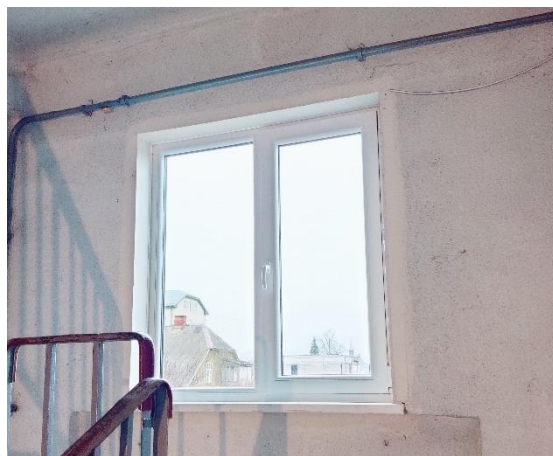
Attēls Nr. 139 Koplietošanas kāpņu telpās 2015.gadā uzstādīti PVC konstrukcijas logi
