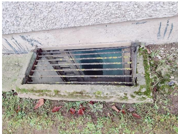
Attēls Nr. 135 Pagrabam saglabājušies vecie koka konstrukcijas logi
