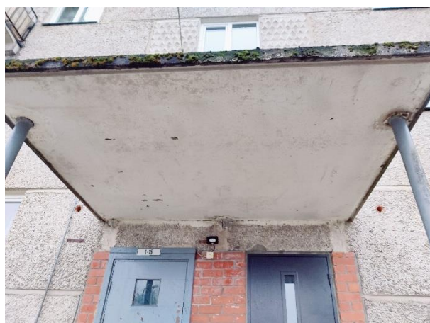
Attēls Nr. 98 Dzelzsbetona plātnes jumtiņa kopskats no apakšpuses (1.k.t.)
