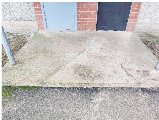
Attēls Nr. 103 3. kāpņu telpas betona lieveņa kopskats
