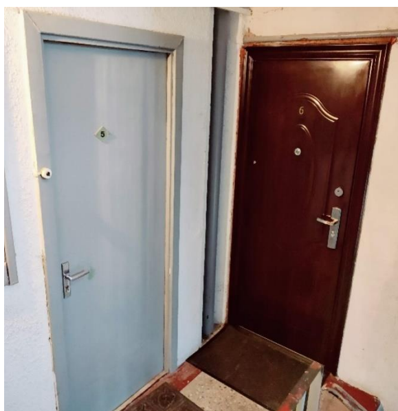
Attēls Nr. 132 Dzīvokļiem uzstādītas dažādu stilu un materiālu ārdurvis, bet tās ir funkcionālā darba kārtībā un apmierinošā stāvoklī
