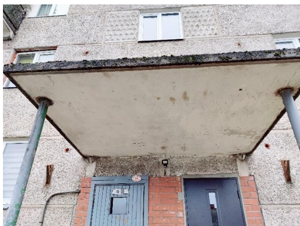
Attēls Nr. 101 Dzelzsbetona plātnes jumtiņa kopskats no apakšpuses (2.k.t.)
