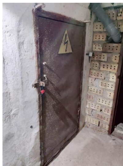
Attēls Nr. 129 Slēdzamas metāla durvis uz ēkas siltummezglu
