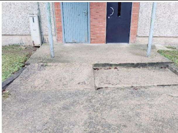
Attēls Nr. 108 Neliels betona panduss 2.kāpņu telpas priekšā
