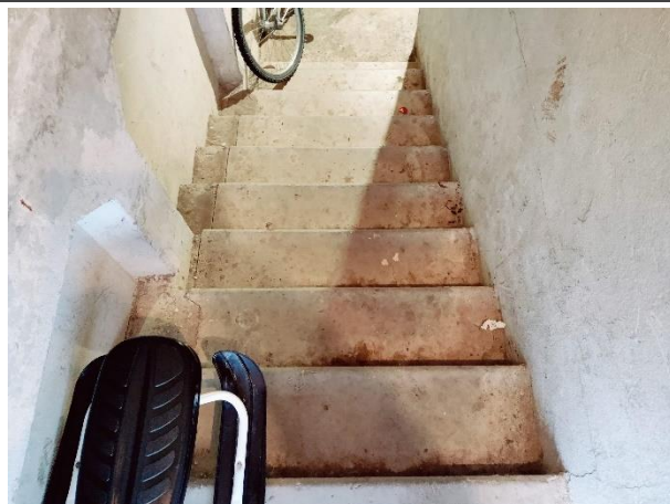
Attēls Nr. 109 Pagraba dzelzsbetona kāpņu kopskats
