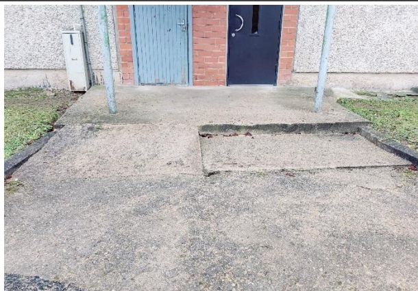
Attēls Nr. 100 2. kāpņu telpas betona lieveņa kopskats
