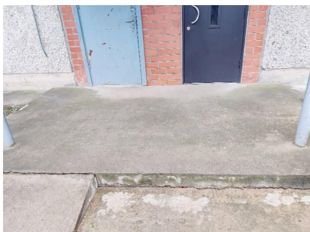
Attēls Nr. 97 Betona lieveņa kopskats pie ieejas 1.kāpņu telpā
