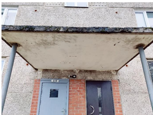
Attēls Nr. 104 Dzelzsbetona plātnes jumtiņa kopskats no apakšpuses (3.k.t.)
