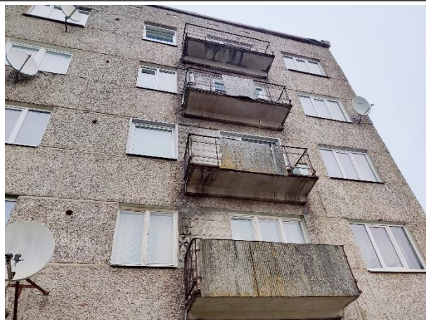
Attēls Nr. 94 Vairākiem balkoniem trūkst daļa vai visas vecās apdares plāksnes
