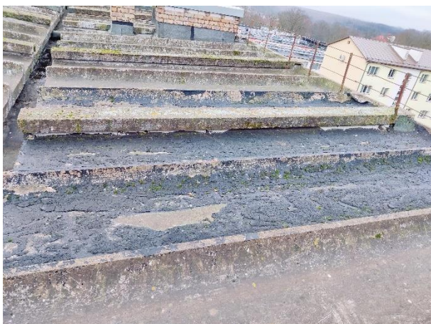
Attēls Nr. 80 Vēsturiski uzklāts hidroizolācijas slānis lokālā vietā, bet tas laika gaitā sadalījies un vairs nav funkcionāls
