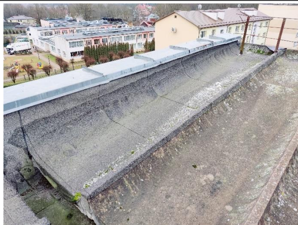
Attēls Nr. 77 Skārda parapeta elementi ir apmierinošā stāvoklī. Lokāli ieklāts jumta hidroizolācijas materiāls
