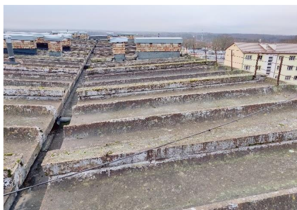
Attēls Nr. 75 Jumta saliekamā dzelzsbetona pārseguma paneļu kopskats. Nav uzklāts jumta hidroizolējošs seguma materiāls
