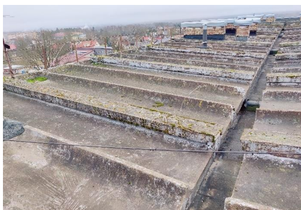
Attēls Nr. 74 Jumta saliekamā dzelzsbetona pārseguma paneļu kopskats. Nav uzklāts jumta hidroizolējošs seguma materiāls
