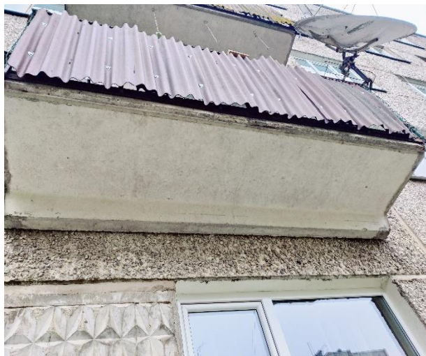
Attēls Nr. 92 Balkonu dzelzsbetona paneļu apakšu virsmas ir apmierinošā stāvoklī
