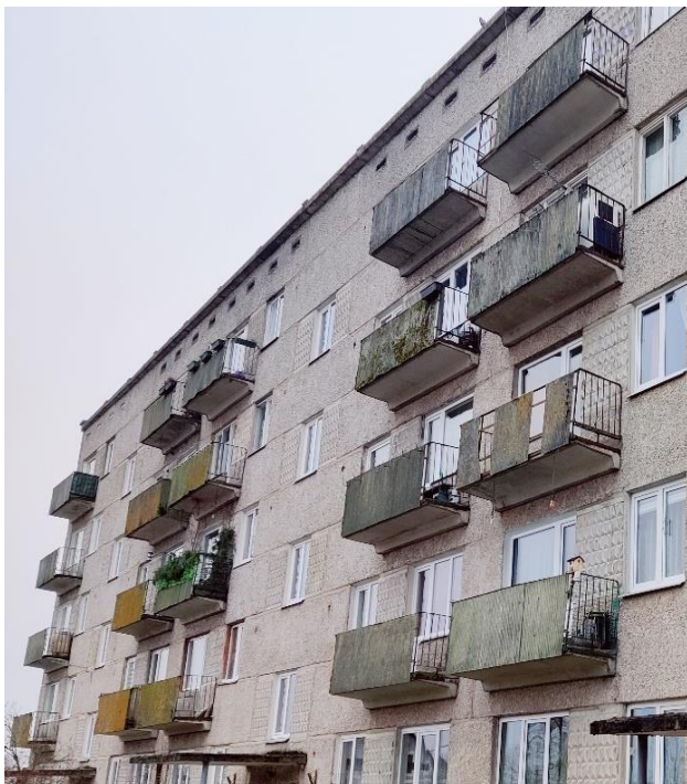
Attēls Nr. 91 Balkonu kopskats, lielākajai daļai kopš ēkas būvēšanas laikiem saglabājušās metāla margas un vēsturiskā viļņoto lokšņu apdare
