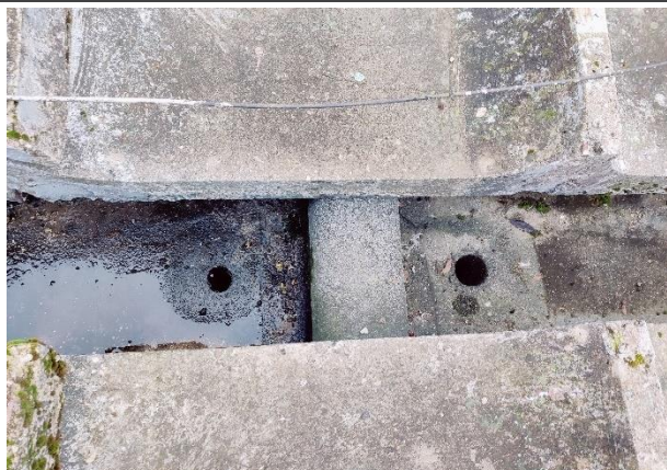
Attēls Nr. 82 lekšējā lietusūdens novadsistēma. Trūkst lapu un gružu ķērāji
