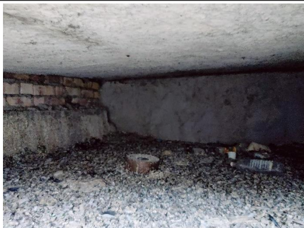
Attēls Nr. 70 Jumta nesošās konstrukcijas – saliekamā dzelzsbetona sijas, saliekamā dzelzsbetona paneļi. Izdedžu maisījums bēniņu telpā
