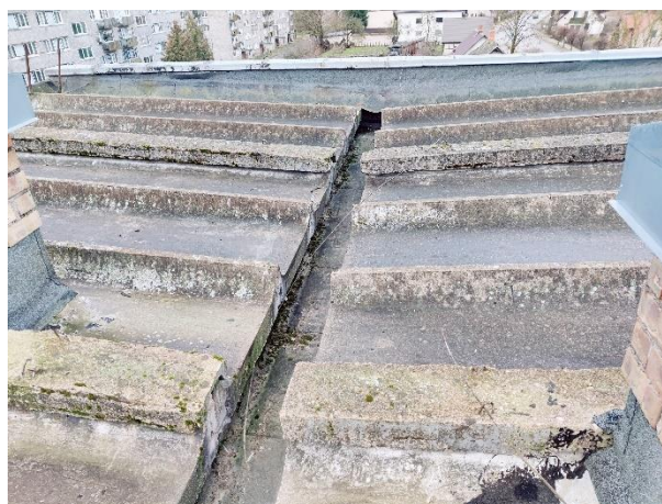
Attēls Nr. 73 Jumta saliekamā dzelzsbetona pārseguma paneļu kopskats. Skārda parapets ir apmierinošā stāvoklī
