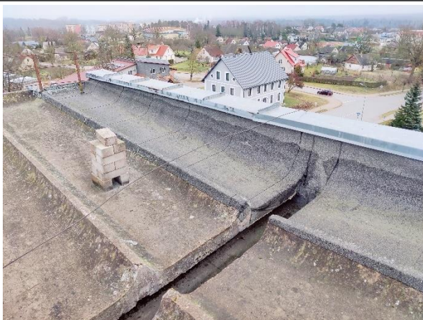
Attēls Nr. 76 Skārda parapeta elementi ir apmierinošā stāvoklī. Lokāli ieklāts jumta hidroizolācijas materiāls
