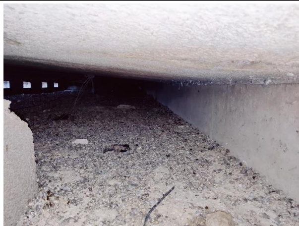
Attēls Nr. 71 Jumta nesošās konstrukcijas – saliekamā dzelzsbetona sijas, saliekamā dzelzsbetona paneļi. Izdedžu maisījums bēniņu telpā
