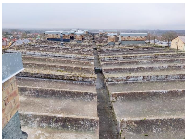
Attēls Nr. 72 Jumta saliekamā dzelzsbetona pārseguma paneļu kopskats
