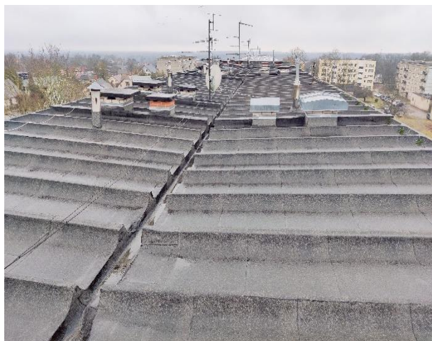
Attēls Nr. 72 Jumta saliekamā dzelzsbetona pārseguma paneļu kopskats
