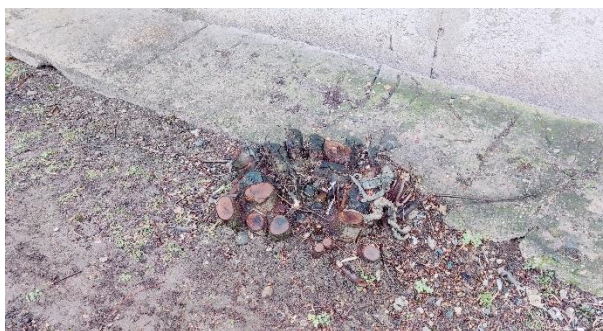
Attēls Nr. 26 Nozāģēti krūmi tiešā ēkas tuvumā – saglabāti celmi!
