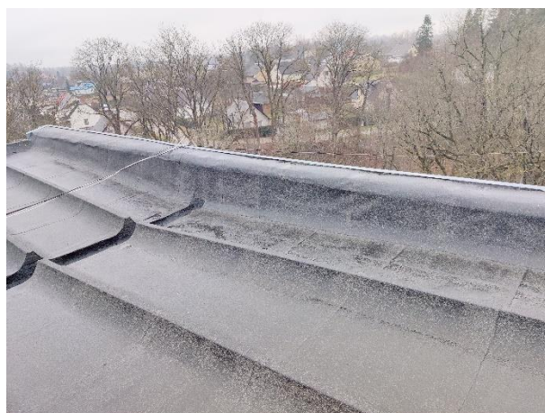
Attēls Nr. 71 Jumta parapeta kopskats
