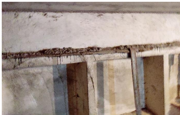
Attēls Nr. 57 Ierīkota bitumena ruļļmateriāla horizontālā hidroizolācija virs pamatu dzelzsbetona paneļiem
