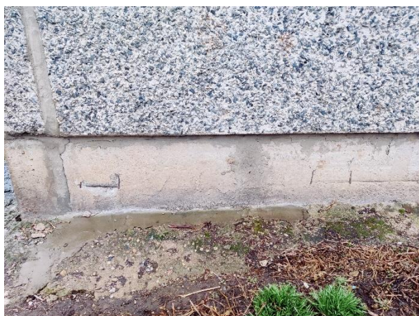
Attēls Nr. 38 Atsegts stiegrojums cokola paneliņiem
