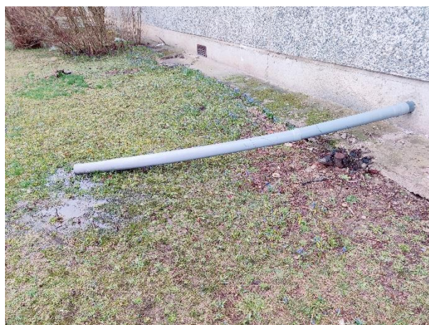
Attēls Nr. 85 Lietusūdens kanalizācijas izvadi ārā no ēkas ir pagarināti un tie ir no PVC materiāla caurulēm
