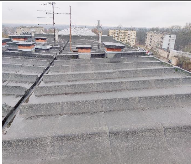
Attēls Nr. 74 Jumta saliekamā dzelzsbetona pārseguma paneļu kopskats
