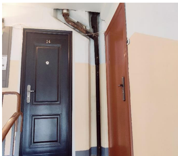
Attēls Nr. 77 1., 2. un 4.kāpņu telpā saglabājušies vecie čuguna cauruļu lietus ūdens stāvvadi
