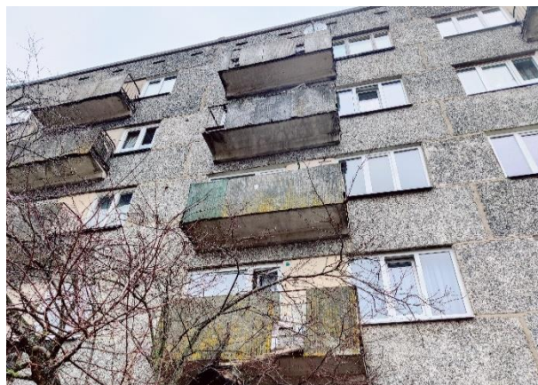
Attēls Nr. 88 Daļai balkonu laika gaitā nokrituši dekoratīvās apdares plāksņu gabali
