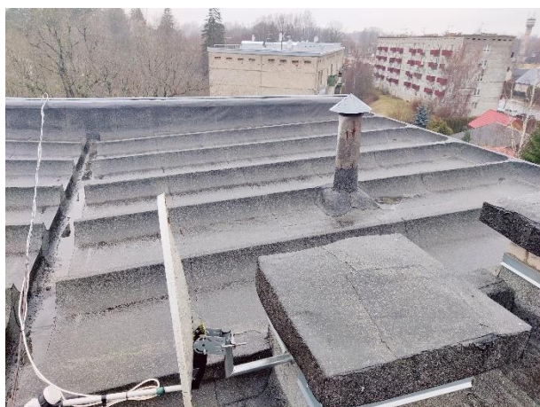
Attēls Nr. 70 Jumta saliekamā dzelzsbetona pārseguma paneļu kopskats. Jumta hidroizolējošais seguma materiāls ir apmierinošā stāvoklī
