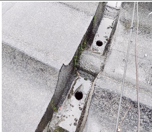
Attēls Nr. 75 Atsevišķām iekšējo lietus ūdens novadsistēmu gūlījām trūkst lapu ķērāji
