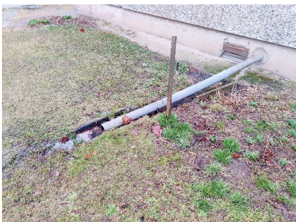
Attēls Nr. 84 Lietusūdens kanalizācijas izvadi ārā no ēkas ir pagarināti un tie ir no PVC materiāla caurulēm
