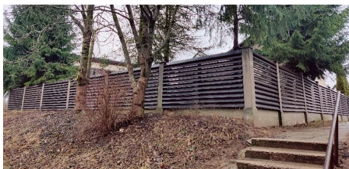
Attēls Nr. 27 Dzelzsbetona stabu un koka sekciju žogs gar Raiņa ielu 35.
