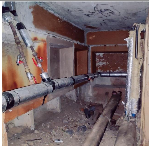
Attēls Nr. 31 Pamatu dzelzsbetona paneļu kopskats
