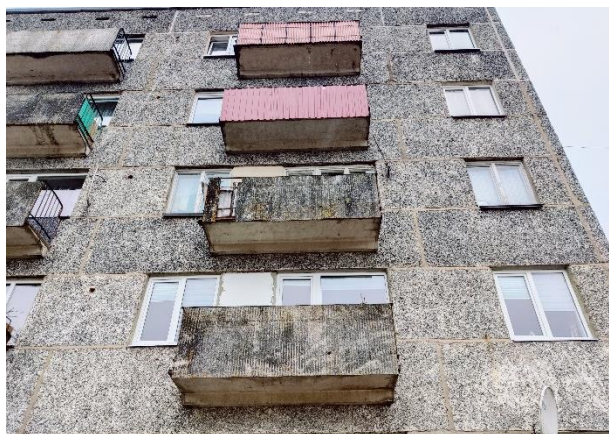
Attēls Nr. 87 Balkonu kopskats, lielākajai daļai kopš ēkas būvēšanas laikiem saglabājušās metāla margas un vēsturiskā viļņoto lokšņu apdare
