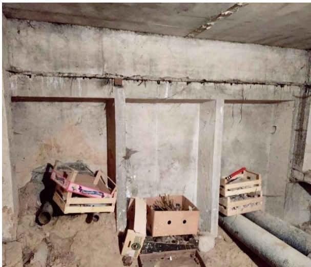
Attēls Nr. 28 Pamatu dzelzsbetona paneļa kopskats. Virs tiem ierīkota horizontālā hidroizolācija
