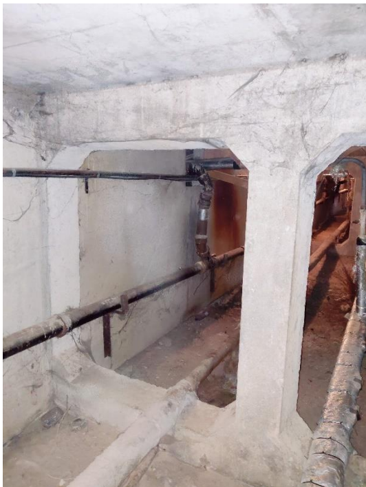
Attēls Nr. 48 Pagarbos esošie paneļi, kas kalpo kā pārseguma balstījums un tajā pašā laikā veido ailu sijas
