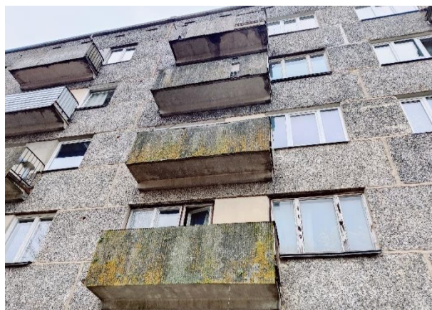
Attēls Nr. 90 Balkonu kopskats. Vecajām apdares plāksnēm sūnu apaugums
