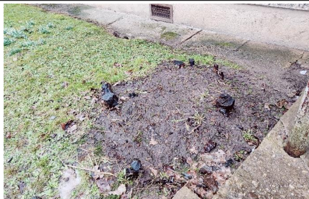
Attēls Nr. 25 Nozāģēti krūmi tiešā ēkas tuvumā – saglabāti celmi!
