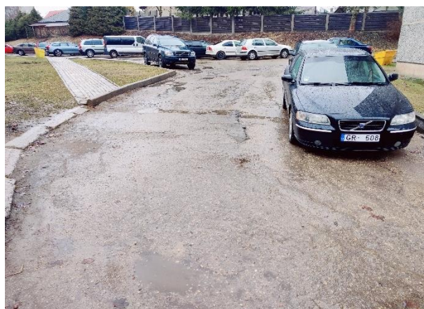
Attēls Nr. 7 Asfalta seguma piebraucamā ceļa kopskats pie ēkas gala sienas
