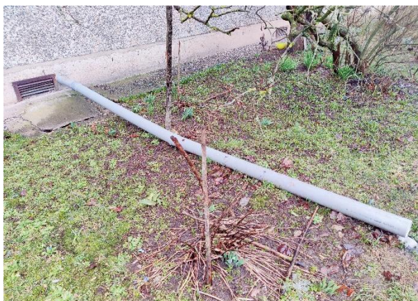
Attēls Nr. 86 Lietusūdens kanalizācijas izvadi ārā no ēkas ir pagarināti un tie ir no PVC materiāla caurulēm
