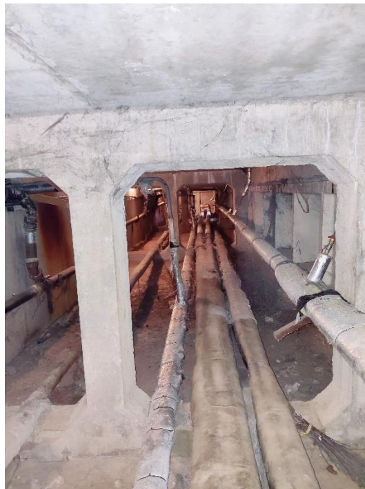
Attēls Nr. 49 Pagarbos esošie paneļi, kas kalpo kā pārseguma balstījums un tajā pašā laikā veido ailu sijas
