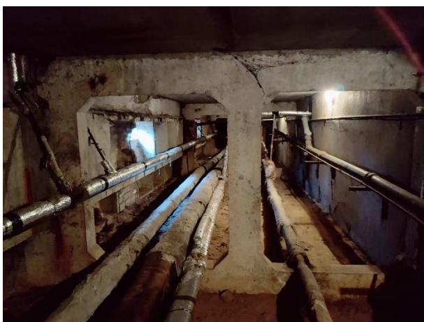
Attēls Nr. 50 Pagarbos esošie paneļi, kas kalpo kā pārseguma balstījums un tajā pašā laikā veido ailu sijas
