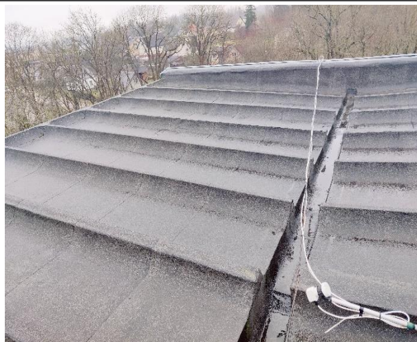
Attēls Nr. 69 Jumta saliekamā dzelzsbetona pārseguma paneļu kopskats no ārpuses
