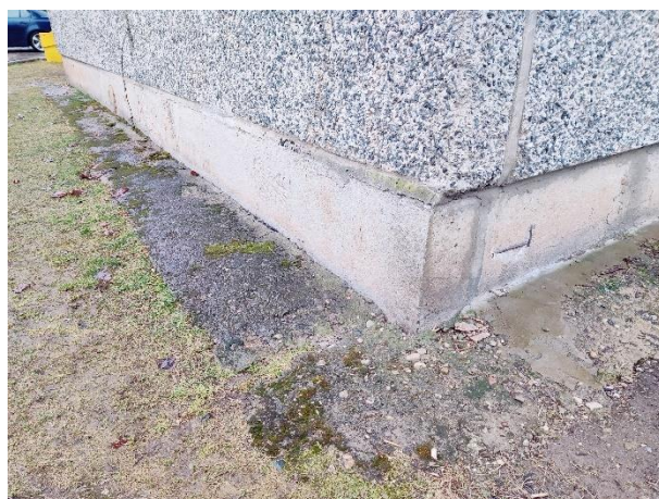
Attēls Nr. 37 Cokola un betona apmales kopskats
