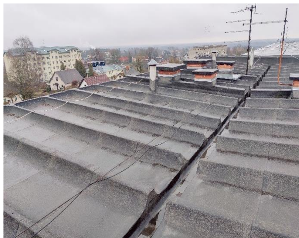
Attēls Nr. 73 Jumta saliekamā dzelzsbetona pārseguma paneļu kopskats
