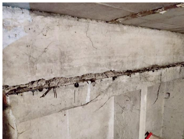
Attēls Nr. 56 Ierīkota bitumena ruļļmateriāla horizontālā hidroizolācija virs pamatu dzelzsbetona paneļiem
