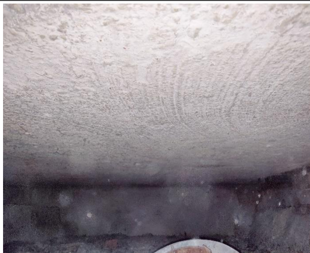
Attēls Nr. 68 Jumta saliekamā dzelzsbetona pārseguma paneļu kopskats
