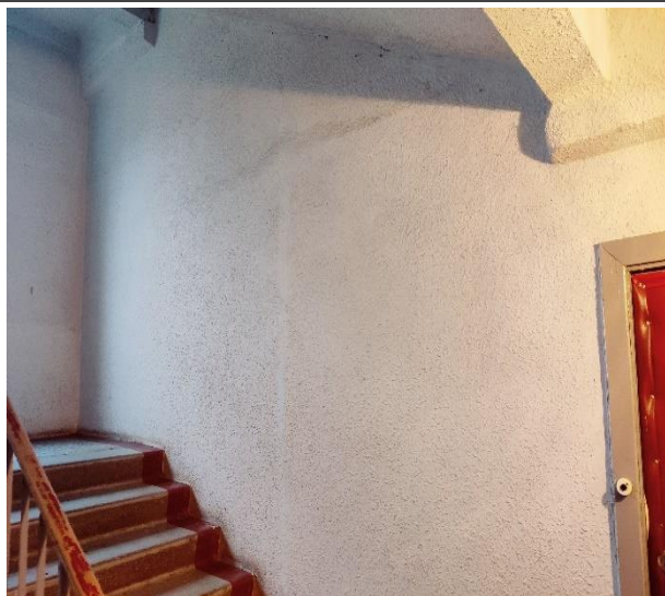
Attēls Nr. 51 Kāpņu telpas nesošās šķērssienas kopskats
