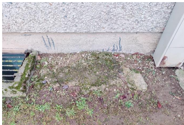
Attēls Nr. 48 Betona apmale laika gaitā pilnībā sairusi – tā vairs nefunkcionē šajā posmā
