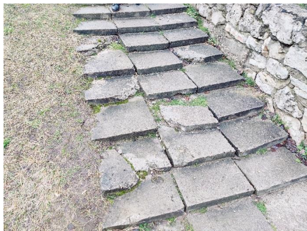
Attēls Nr. 15 Daudzām betona plāksnēm nodrupušas malas. Pakāpieni nav plakniski. Pastāv liels iedzīvotāju pakļūšanas un savainošanās risks!
