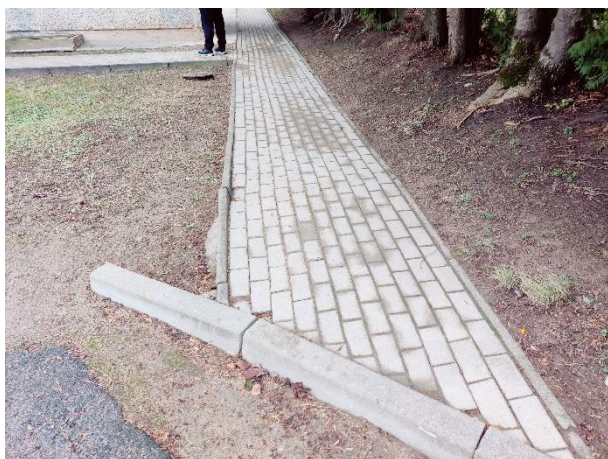
Attēls Nr. 11 Betona bruģa ietve izbūvēta gar vienu ēkas gala sienu. Tā ir apmierinošā stāvoklī
