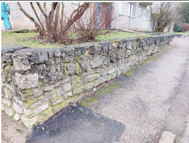
Attēls Nr. 31 Atbalstsienas turpinājums ēkas 1.kāpņu telpas priekšā
