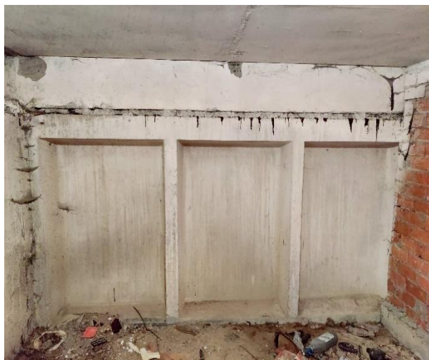
Attēls Nr. 35 Pamatu dzelzsbetona paneļa kopskats. Virs tiem ierīkota horizontālā hidroizolācija
