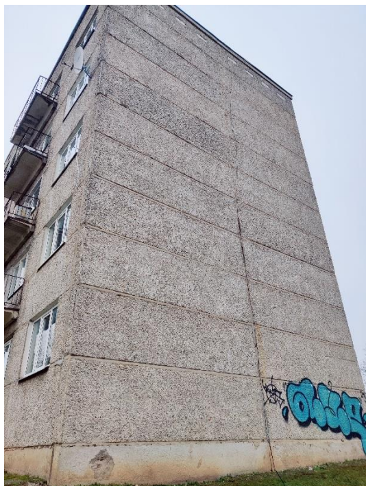
Attēls Nr. 53 Nesošās dzelzsbetona paneļu gala sienas kopskats
