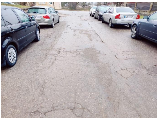
Attēls Nr. 8 Asfalta seguma brauktuves kopskats, kas ved gar ēku no Raiņa ielas
