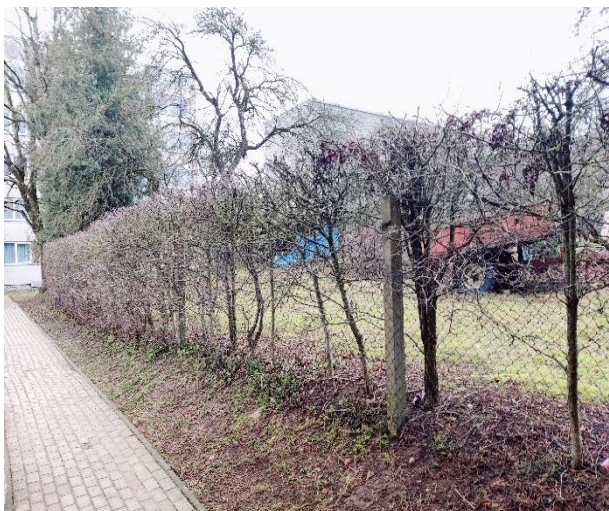
Attēls Nr. 27 Dzelzsbetona stabu un drāšu pinuma žogs gar Raiņa ielu 25.
