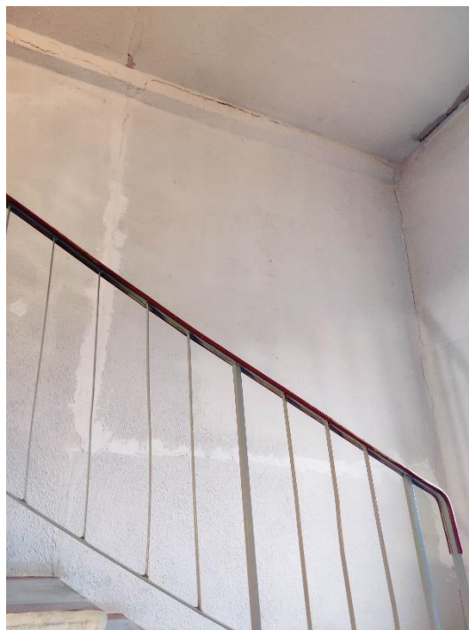
Attēls Nr. 50 Daļēji aizdarītas plaisas kāpņu telpas nesošajās šķērssienās
