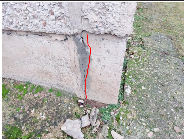
Attēls Nr. 44 Plaisa šuvē starp paneļiem. Šajā stūrī ir iepriekš veikta ģeotehniskā izpēte
