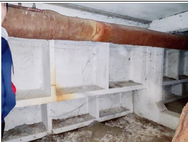
Attēls Nr. 37 Pamatu dzelzsbetona paneļa kopskats
