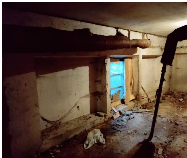
Attēls Nr. 36 Pamatu dzelzsbetona paneļa, ar pagaba logu, kopskats
