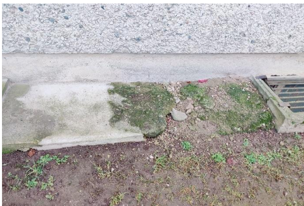
Attēls Nr. 47 Caur pamatiem no jauna izbūvēta PVC lietussūdens novadcaurule, lokāli atjaunota betona apmale. Blakus posms sliktā stāvoklī
