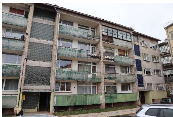
Ēkas A fasāde
