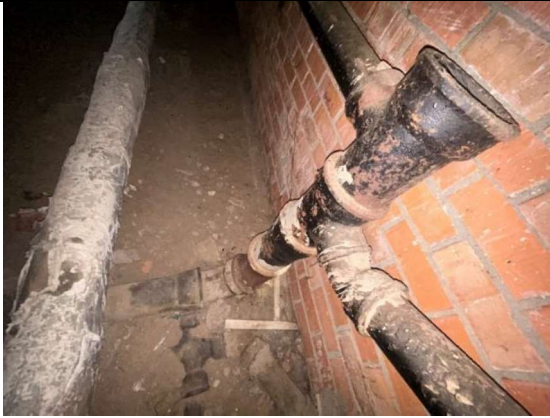
5.1.5. att. Oriģinālās čuguna kanalizācijas caurules ar atvērumu
