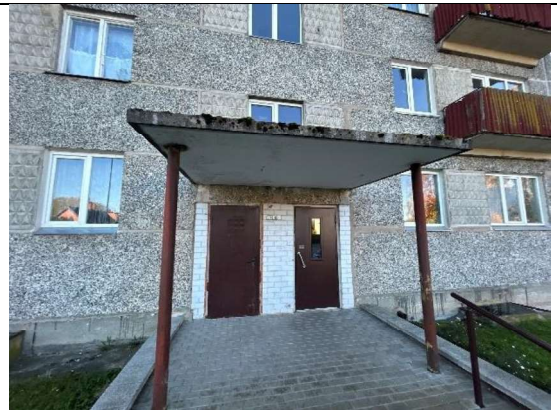
4.13.4. att. Mainītas ārdurvis ( pa perimetru nepieguļošas ailei)
