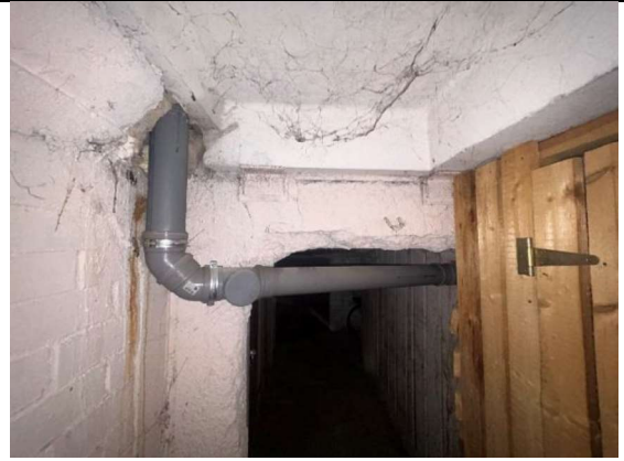
5.1.6. att. PVC notekūdens cauruļu posmi
