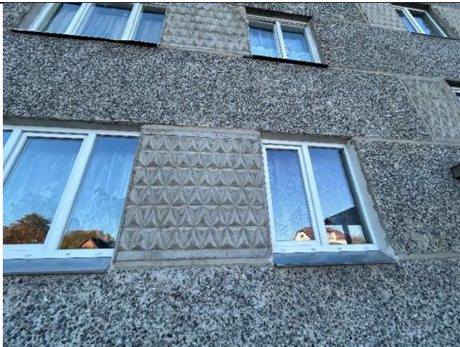
4.19.1. att. Vieglobetona paneļu siena ar dekoratīvu akmentiņu apdari un starplogu daļai apdare uz cementa bāzes ar izveidotu ornamentu
