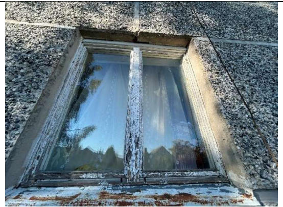
4.13.2. att. Oriģinālais koka konstrukcijas logs 1. st. tuvplānā
