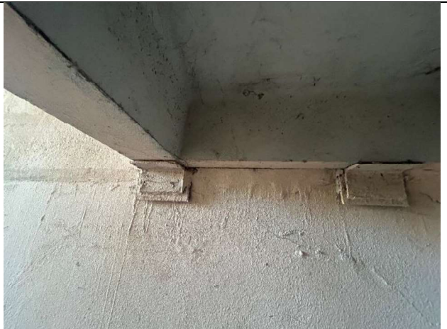
4.10.6. att. Vietām pilnībā neapstrādāti un korodējuši enkurotie metāla kāpņu laukumu atbalsti pagrabā.
