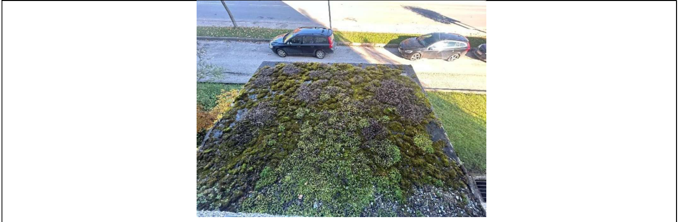
4.9.10. att. Veģetatīvi apaudzis un bojāts, saplaisājis ieejas jumtiņa segums
