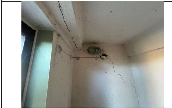
4.10.7. att. Plaisa kāpņu laukuma konstrukcijā
