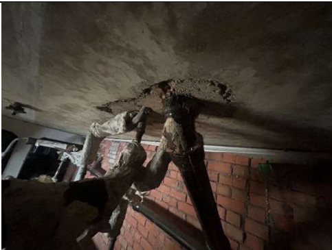
4.6.3. att. Pagraba griesti - inženierkomunikāciju šķērsojuma vieta ar atjaunotu aizpildījumu
