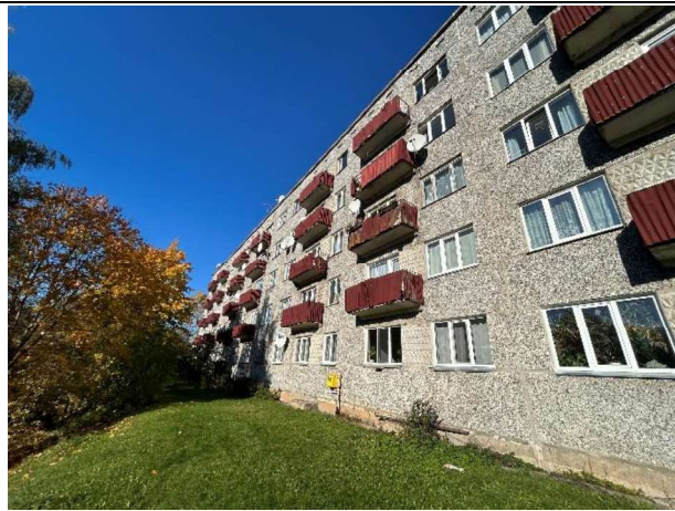
3.1.3. att. Ēkai dienvidu fasādei pieguļošais laukums
