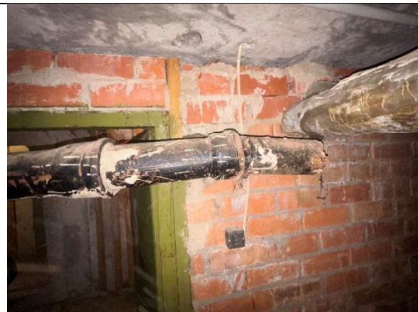
5.1.3. att. Neizmantots kanalizācijas caurules fragments
