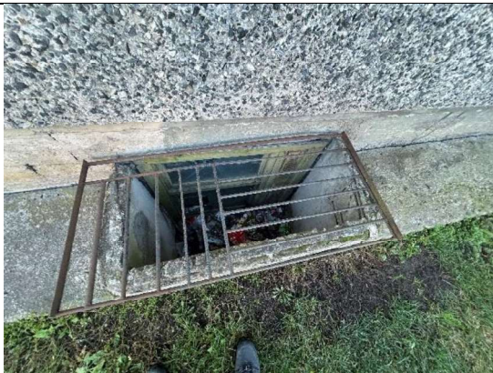
4.13.3. att. Pagraba koka konstrukcijas logailas aizpildījums
