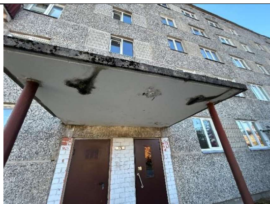
4.9.2. att. Mitruma radīti bojājumi ieejas lieveņa jumtiņam
