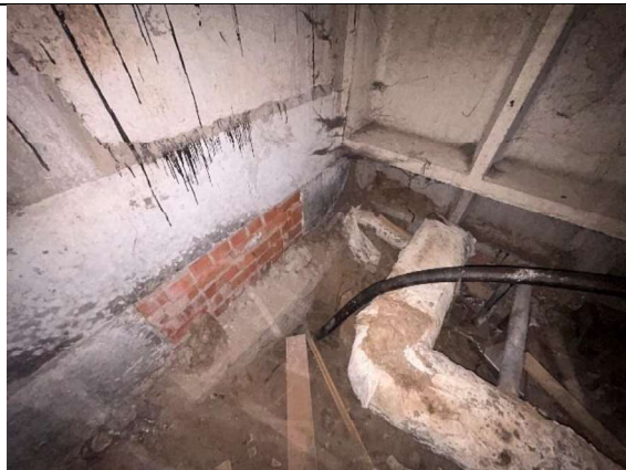
5.1.1. att. Aukstā ūdens ievads
