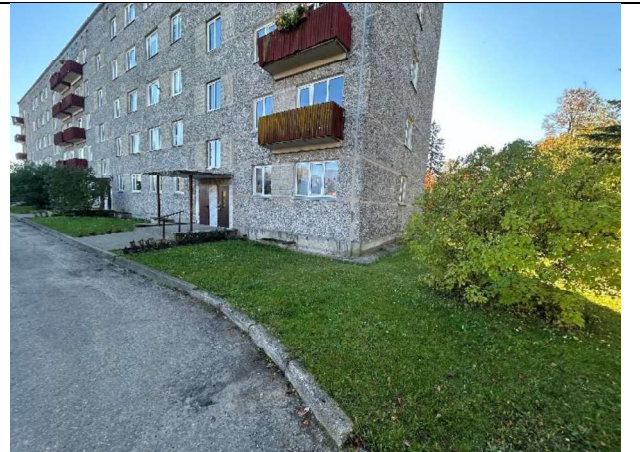
3.1.6. att. Ziemeļu fasādes nemainīto brauktuves apmaļu fragments
