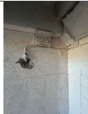
4.18.4. att. Apdares nodrupumi inženierkomunikāciju šķērsojumu vietā
