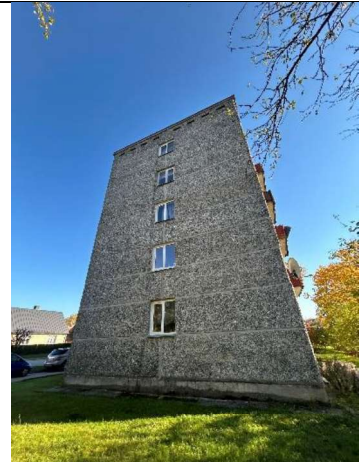
3.1.4. att. Ēkas rietumu fasādei pieguļošais laukums
