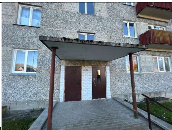
4.9.1. att. Bruģēts ieejas lieveņi un jumtiņš ar metāla atbalsta stabiem
