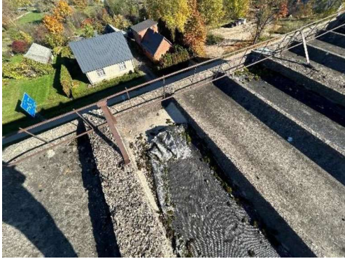
4.8.7. att. Vairākās vietās veikti hidroizolācijas uzlabošanas darbi, lokāli materiāls ir nolietojies
