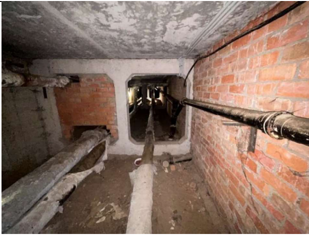
4.1.3. att. Pagraba nesošās atvieglota tipa betona gatavkonstrukciju paneļu sienas ar atvērumiem, kuri pēc nepieciešamības aizmūrēti telpu atdalīšanai
