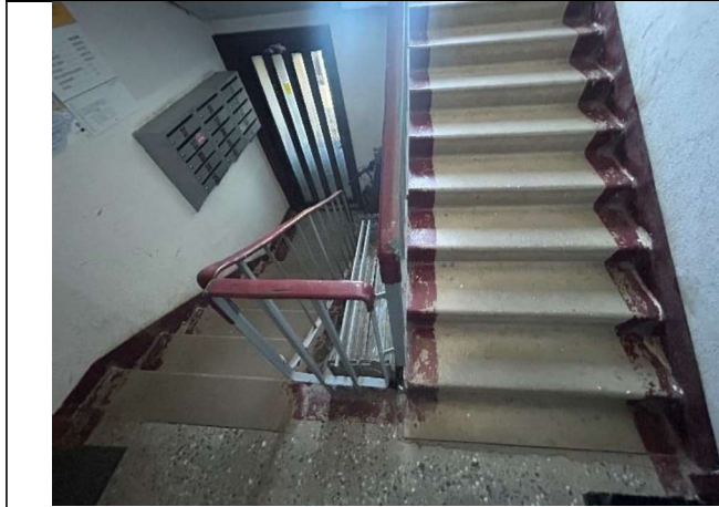
4.10.3. att. Tērauda konstrukcijas margas un margas enkurojums pie pakāpiena
