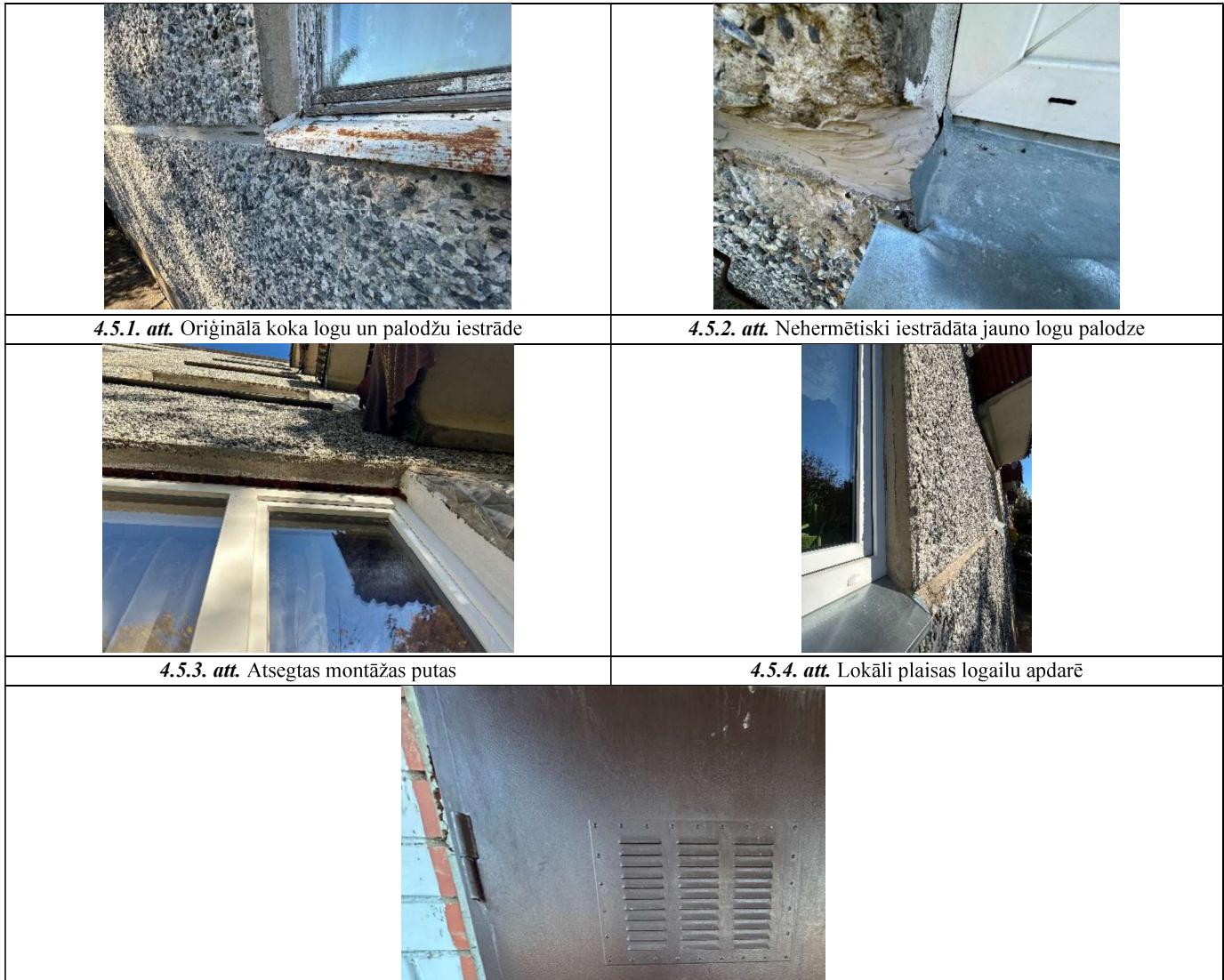
4.5.5. att. Bojāta jauno ārdurvju apdare atsedzot montāžas putas
