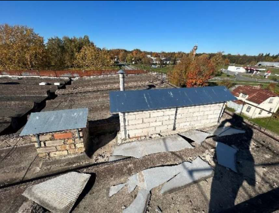
4.8.5. att. Vairākās vietās uz jumta dažādi demontēti elementi, kas stirpa vēja gadījumā var radīt bīstamību
