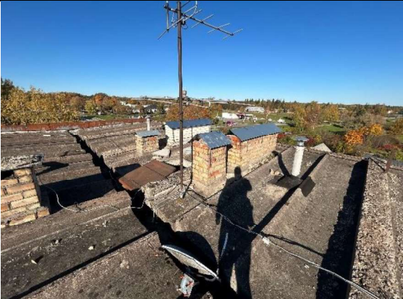
4.8.6. att. Vairākās vietās dažādi demontēti elementi, arī teknēs, radot aizsprostošanas risku
