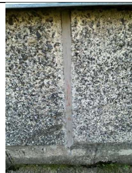
4.2.2. att. Vairākās vietās hermetizēta aizpildījuma šuve
