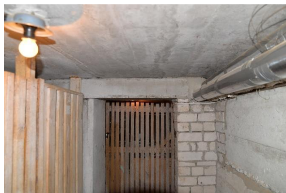
4.5.4.att. Pagraba pārsegums - nesiltināts
