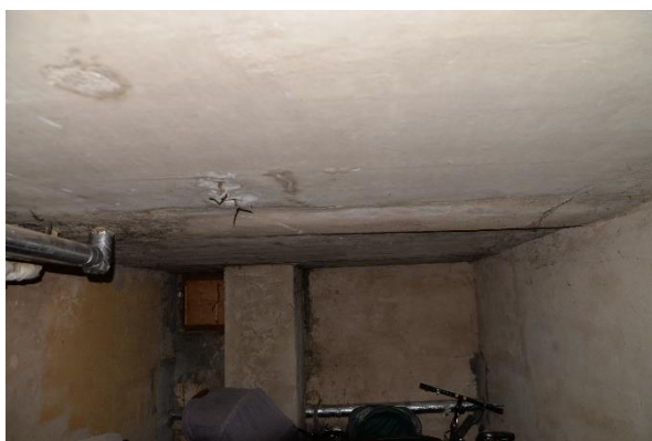
4.5.3.att. Pagraba pārsegums - siltināts
