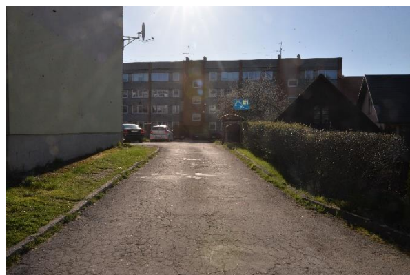
3.1.2.att. Asfalta segums
