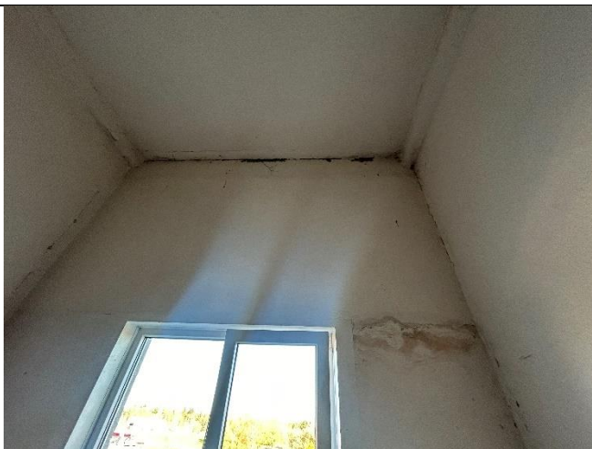
4.18.7. att. Plaisas un mitruma radīti bojājumi ārsienas paneļu šuvju vietās
