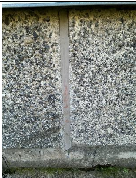
4.2.2. att. Vairākās vietās hermetizēta aizpildījuma šuve
