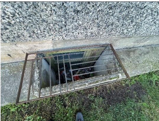
4.13.3. att. Pagraba koka konstrukcijas logailas aizpildījums
