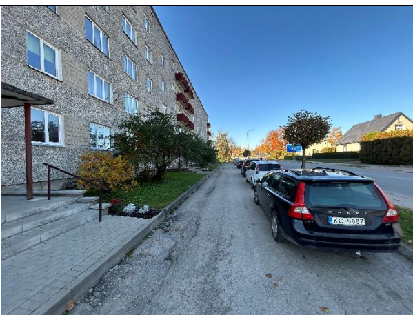
3.1.5. att. Ziemeļu fasādes asfalta seguma bojājumi un bruģakmens pieslīgums kāpņu telpas ieejas platformai
