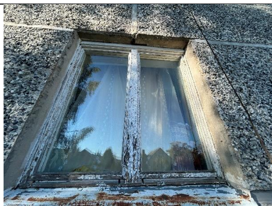
4.13.2. att. Oriģinālais koka konstrukcijas logs 1. st. tuvplānā
