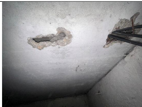
4.6.4. att. Pagraba griesti - inženierkomunikāciju šķērsojuma vieta bez aizpildījuma, ar atsegtu, deformētu un korodējošu stiegrojumu
