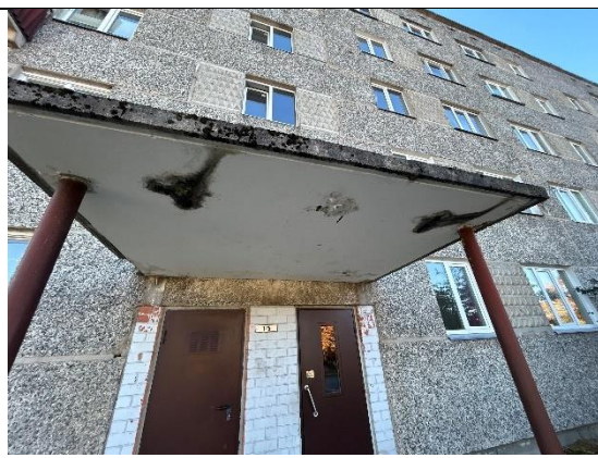
4.9.2. att. Mitruma radīti bojājumi ieejas lieveņa jumtiņam
