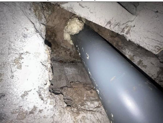
4.6.5. att. Pagraba griesti - inženierkomunikāciju šķērsojuma vieta aizpildījumam izmantojot montāžas putas
