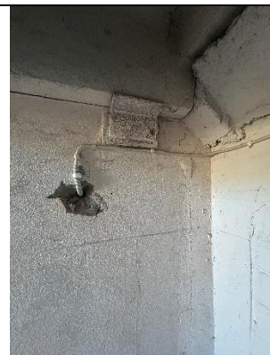
4.18.4. att. Apdares nodrupumi inženierkomunikāciju šķērsojumu vietā
