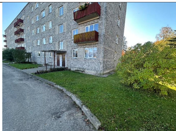
3.1.6. att. Ziemeļu fasādes nemainīto brauktuves apmaļu fragments
