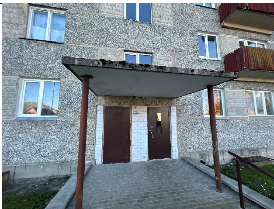
4.13.4. att. Mainītas ārdurvis ( pa perimetru nepieguļošas ailei)
