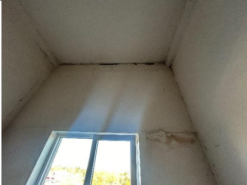
4.2.3. att. Vairākās vietās kāpņu telpās novērojamas plaisas starp ārsienu un starpsienu, mitruma radīti bojājumi apdarē ārsienas paneļu šuvju vietā
