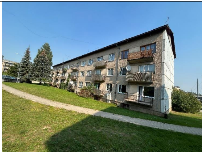
4.2.2. att. Saliekamo vieglbetona paneļu ārsienas – rietumu puse
