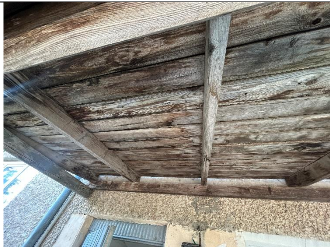
4.9.2. att. Mitruma pleķi uz ieejas jumtiņa koka konstrukcijas
