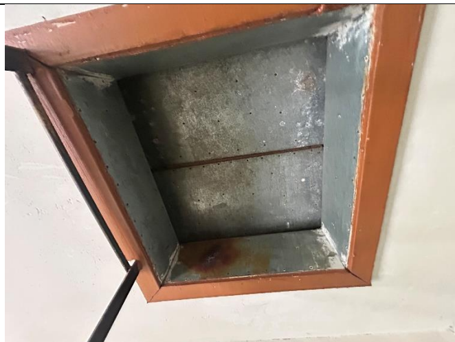
4.13.2. att. Veca koka konstrukcijas lūka uz bēniņiem ar metāla apda
