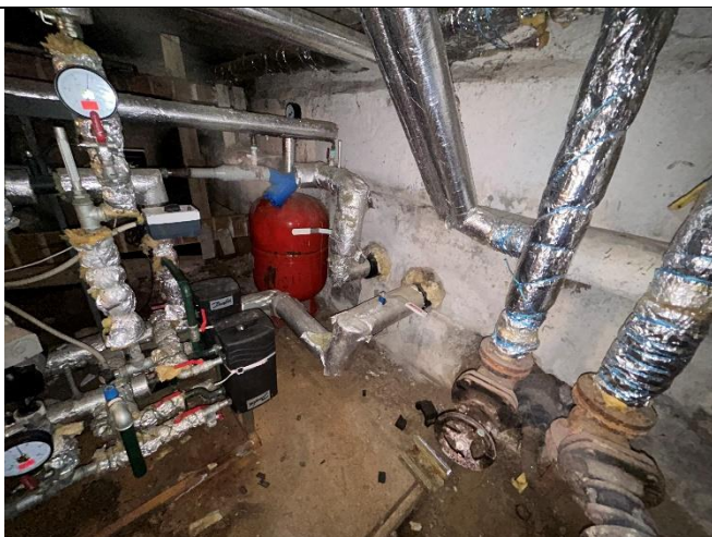
5.2.1. att. Katlu mājas siltumtrases pieslēgums ēkas siltummezglam
