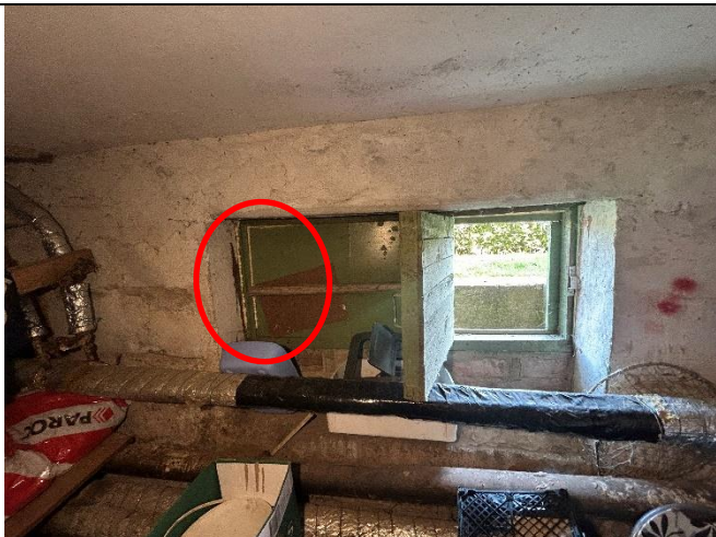
4.5.3. att. Oriģinālais pagraba ailes koka konstrukcijas aizpildījums, pa perimetru aizpūsts ar celtniecības putām
