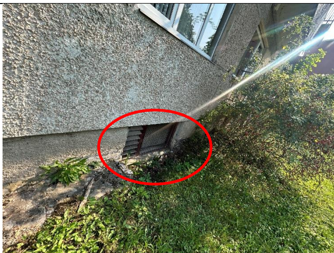
4.1.9. att. vairākās vietās pagraba logaila ar iztrūkstošu aizsargapmali
