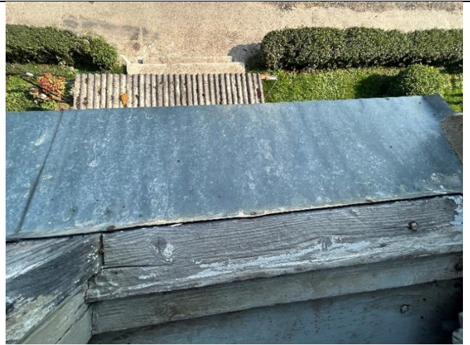
4.5.2. att. Skārda palodzes pieslēgums oriģinālajam koka logam – nehermētiska iestrāde
