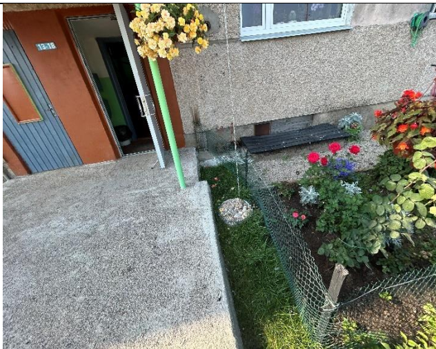
4.8.15. att. Lietus ūdens novadīšana pamatu tuvumā un tiešā ieejas lieveņa grīdas tuvumā
