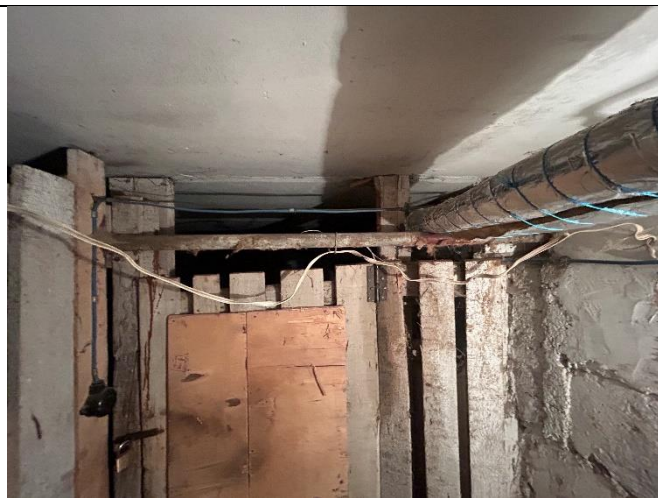
5.6.1. att. Vairākās vietās nesakārtoti elektrības vadi pagraba koplietošanas telpās
