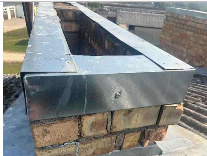
5.5.2. att. Ventilācijas izvadkanāls ar skārda nosegecpurēm
