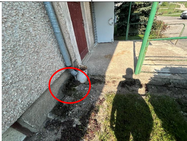
4.1.9. att. vairākās vietās pagraba logaila ar iztrūkstošu aizsargapmali
