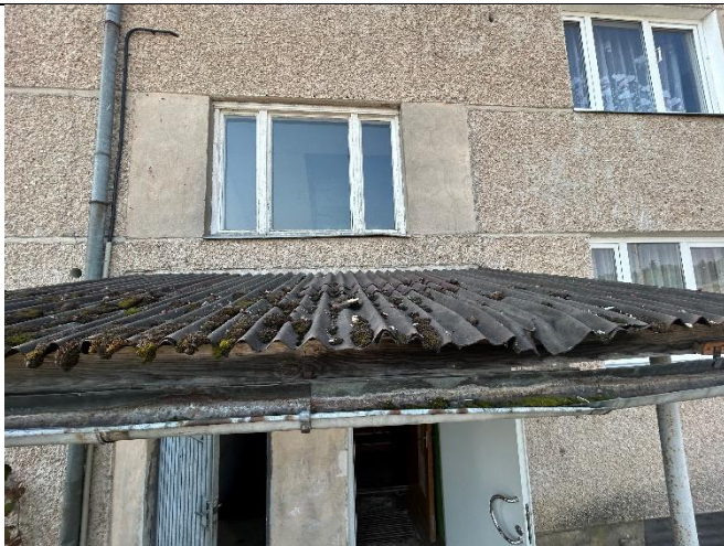
4.9.1. att. Ieejas jumtiņa bitumena viļņotais segums
