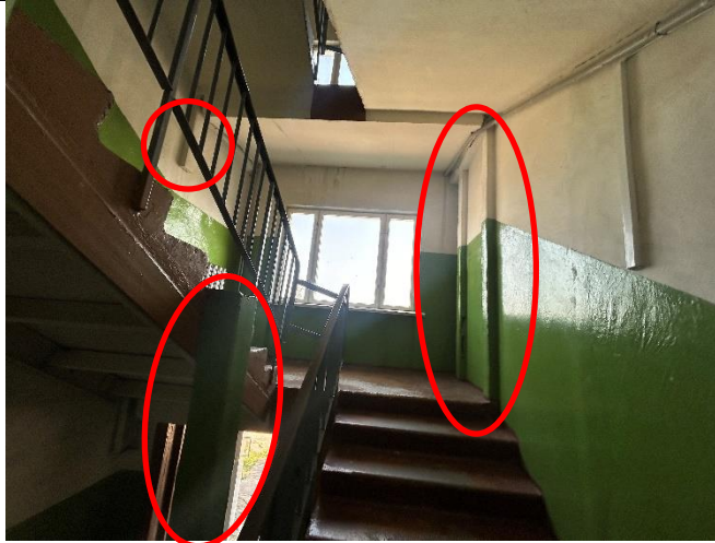
4.7.1. att. Kāpņu telpas kāpņu konstrukcijas papildus stiprinājumi
