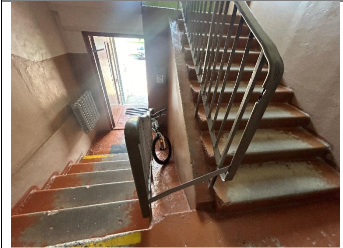
4.18.1. att. Iekšējā apdare koplietošanas kāpņu telpā – nodilusi pakāpienu krāsa, krāsotas un apmetas sienas
