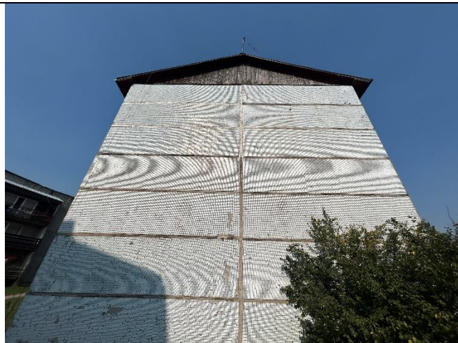
4.2.1. att. Saliekamo vieglbetona paneļu ārsienas – dienvidu puse
