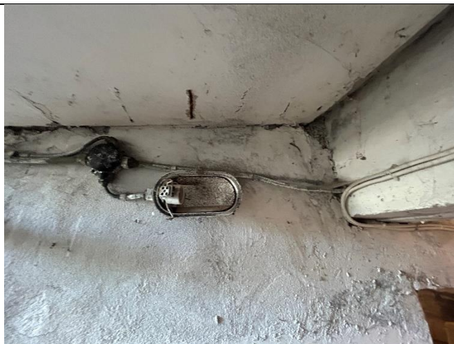
5.6.2. att. Lokāli atsegti kontakti spuldzēm
