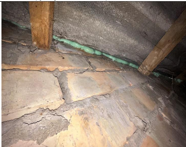
4.8.9. att. Ar montāžas putām aizpildīts seguma pieslēgums izvadkanālam no iekšpuses
