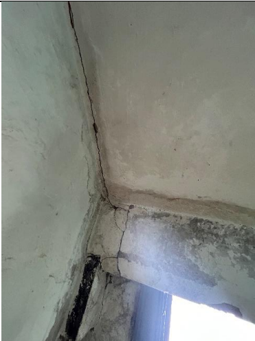
4.18.2. att. Iekšējā apdare koplietošanas kāpņu telpās – vairākās vietās plaisas apdarē un nolobījusies krāsa.
