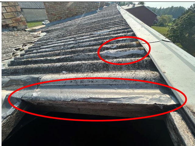
4.8.5. att. Azbestcimenta seguma labojumi ar hermētiķi un pašlīmējošām loksņēm uz bituma bāzes
