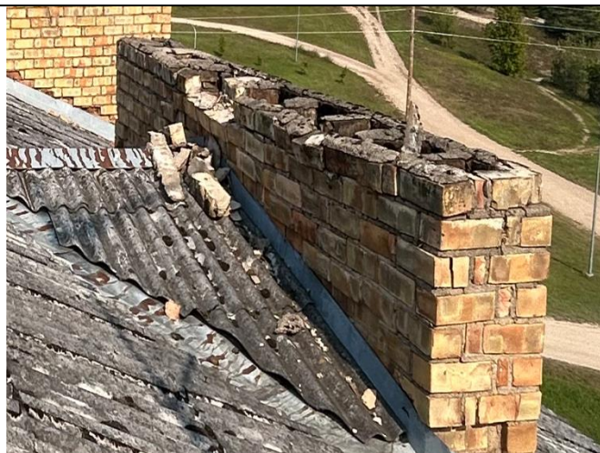
5.5.1. att. Ventilācijas izvadkanāls virs jumta ar plaisām un nodrupumiem
