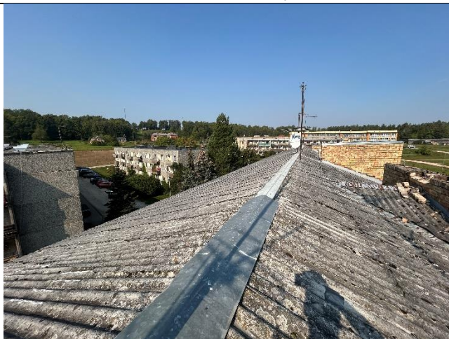
4.8.1. att. Jumta azbestcimenta segums ar skārda nosegelementu pa kori
