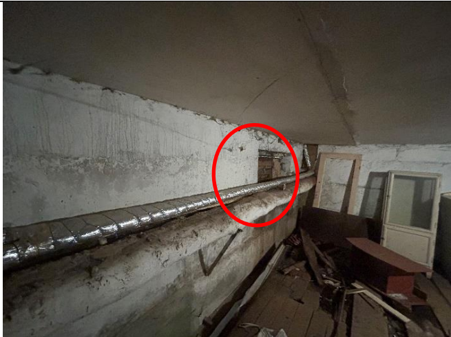
4.5.1. att. Mitrums uz pamata konstrukcijas zem pagraba loga
