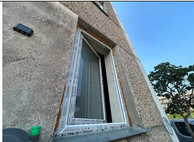
4.5.2. att. Skārda palodzes pieslēgums oriģinālajam koka logam – nehermētiska iestrāde
