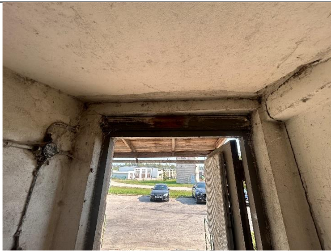
4.2.5. att. Plaisas un spraugas ārsienu un satrpsienu savienojuma vietās
