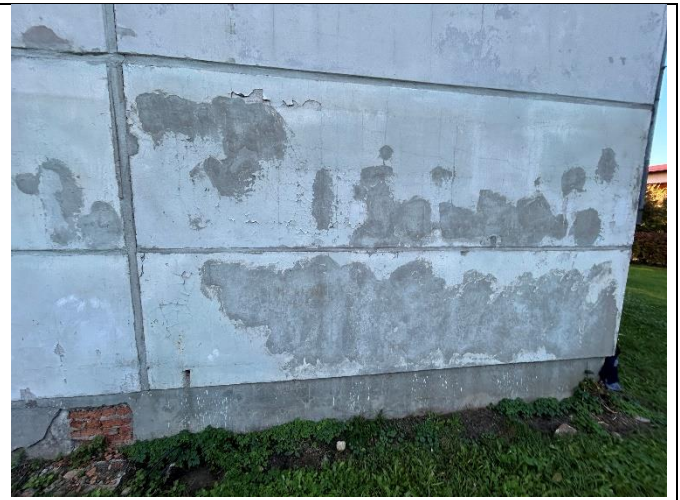
4.19.2. att. Vairākās vietās paneļu siena špaktelēta un lobās apdares virskārta
