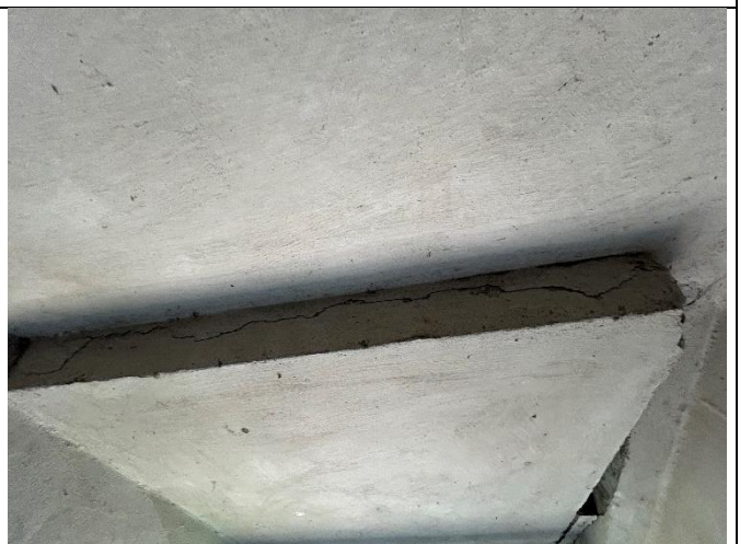
4.10.6. att. Plaisa kāpņu laukuma konstrukcijā
