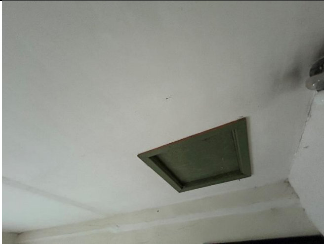
4.13.5. att. Nemainīta koka konstrukcijas lūka uz bēniņiem
