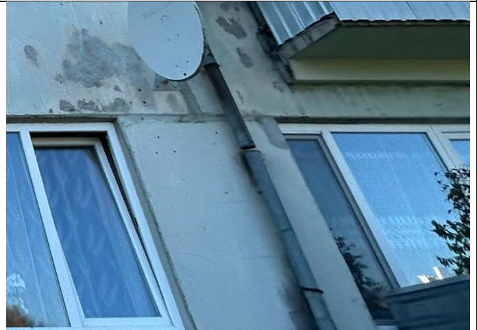
4.8.12. att. Notekcaurules atvienojušās savienojuma vietā
