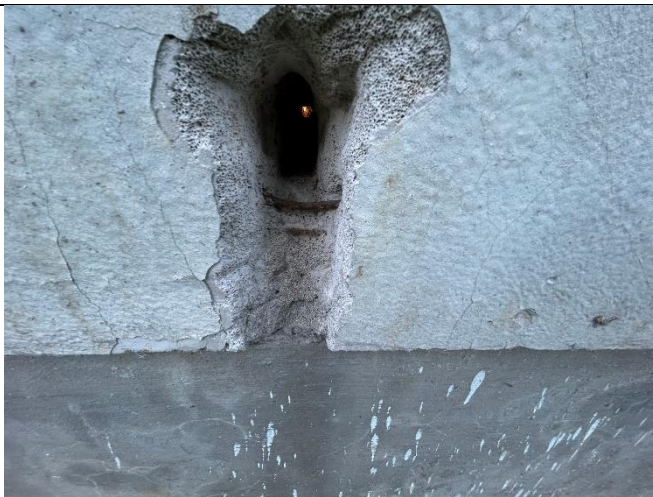
4.2.11. att. Vieglobetona panelis ar atsegtu stiegrojumu
