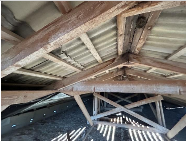
4.8.5. att. Vairākās vietās ar mitrumu piesūkušies koka elementi
