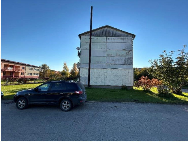
3.1.1. att. Ēkai pieguļošs zāliens un asfaltēta brauktuve gar ziemeļu fasādi
