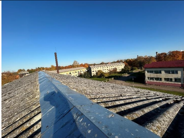
4.8.7. att. Kores skārda nosegelementi
