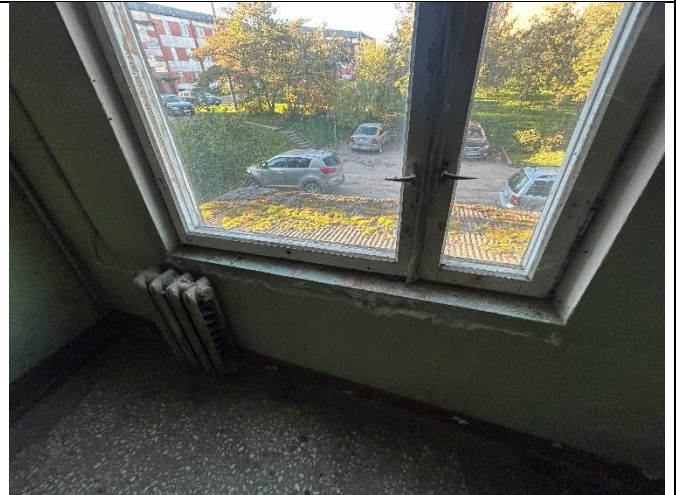
4.13.2. att. Nemainīts koka konstrukcijas logs ar dubultu stiklojumu
