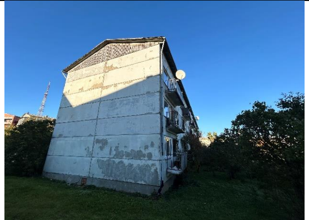
4.2.8. att. Vieglobetona paneļu ārēsiena
