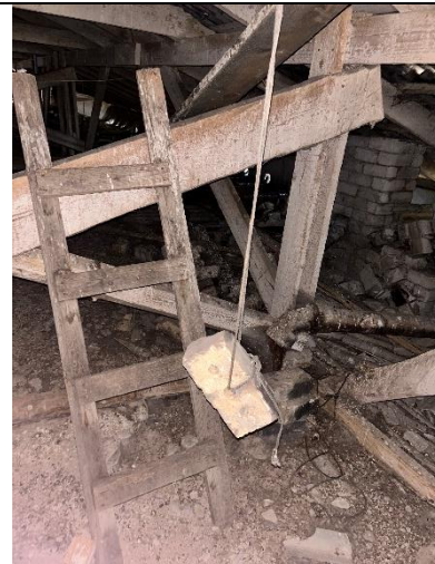
4.8.15. att. Atsvars (ķieģelis) jumta lūkas noturēšanai pozīcijā
