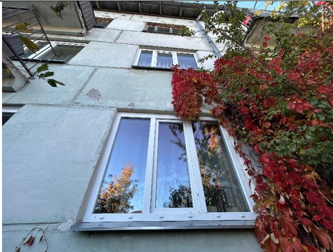
4.13.1. att. Mainīts PCV konstrukcijas logs ar stikla paketi
