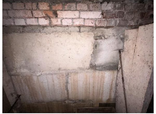
4.1.8. att. Pamatu dzelzsbetona bloku konstrukcija
