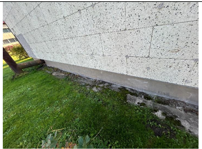
4.5.6. att. Lokāli siltināta ārējsiena pirmā stāva līmenī ar spraugām starp loksniem, atsevišķām loksniem nepietiekams dībeļu skaits
