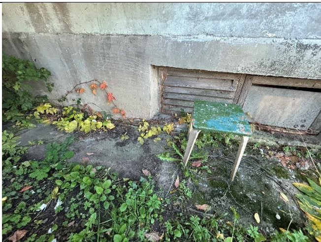
4.5.7. att. Pagraba logs ar ventilācijas resti un stiklojuma iestrāde ar spraugām
