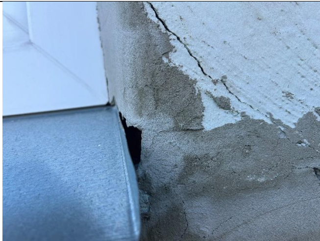
4.5.1. att. Nehermētiski iestrādāta palodze ar spraugām
