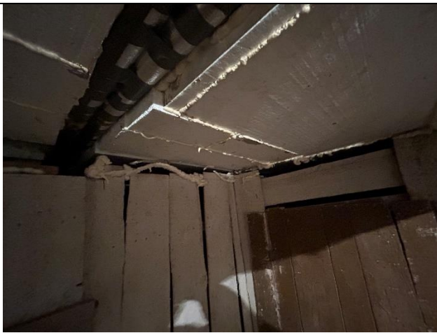
4.5.5. att. Lokāli siltināti neapkurinātā pagraba griesti
