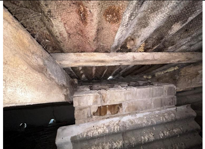
5.5.2. att. Ventilācijas izvadkanāls bēniņos
