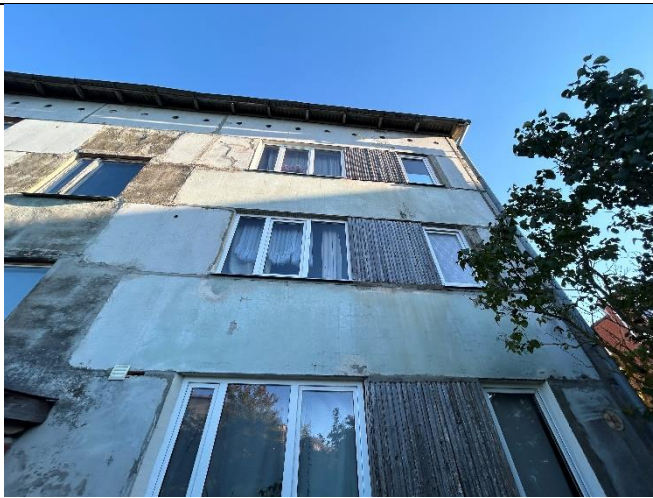
4.2.9. att. Starplogu aizpildījuma koka konstrukcijas dzīvokļu daļām.
