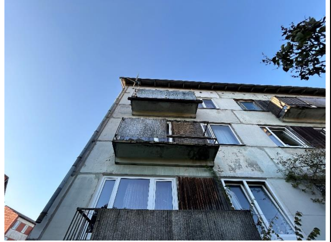
4.9.4. att. Vairāki balkoni ar mitruma radītiem pleķiem
