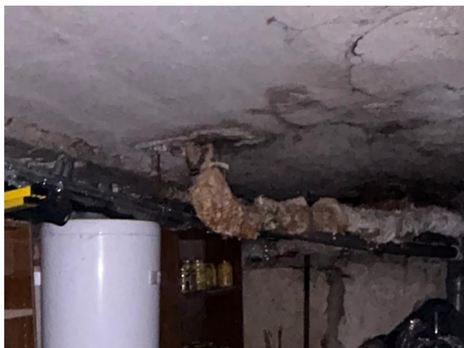
4.6.2. att. Atvērumi komunikāciju šķērsošanai pagraba griestu plātnē
