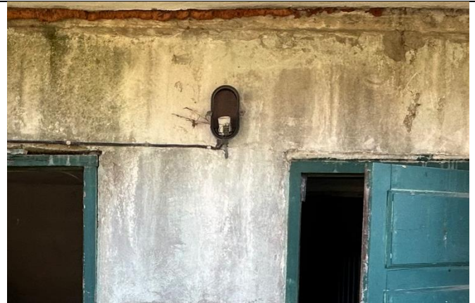
5.6.2. att. vairākās vietās atsegti spuldzu kontakti
