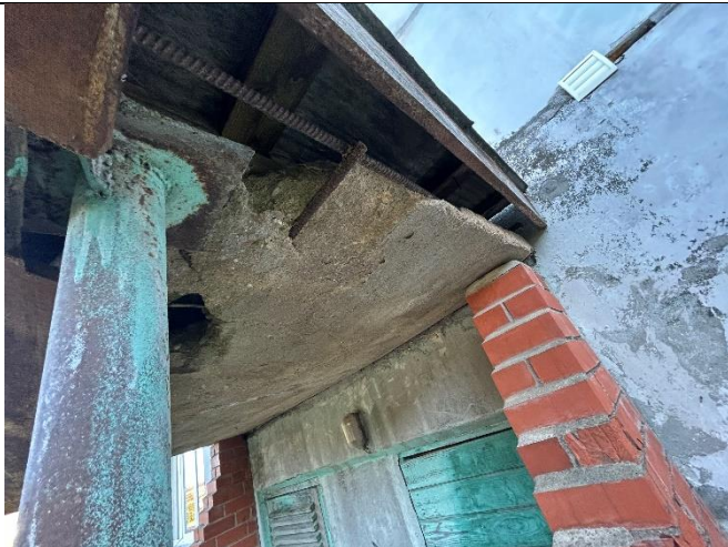
4.9.7. att. Būtiski ieejas juntiņa nodrupumi, atsegts un korodējis stiebrojums – pirmsavārijas stāvoklis
