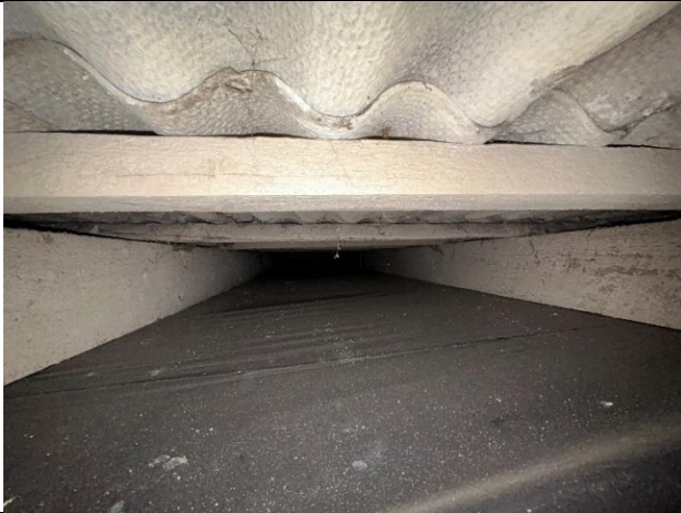
4.8.1. att. Zem azbestcmenta lokšņu seguma uzstādīta plēve, iespējams, ar nolūku novadīt lietus ūdeni vietās, kur segums ir bojāts
