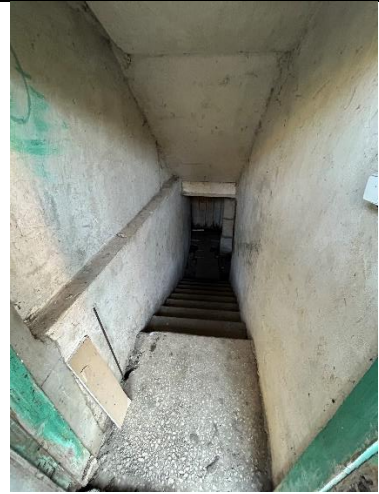
4.10.2. att. Betona kāpņu konstrukcija pagraba daļai
