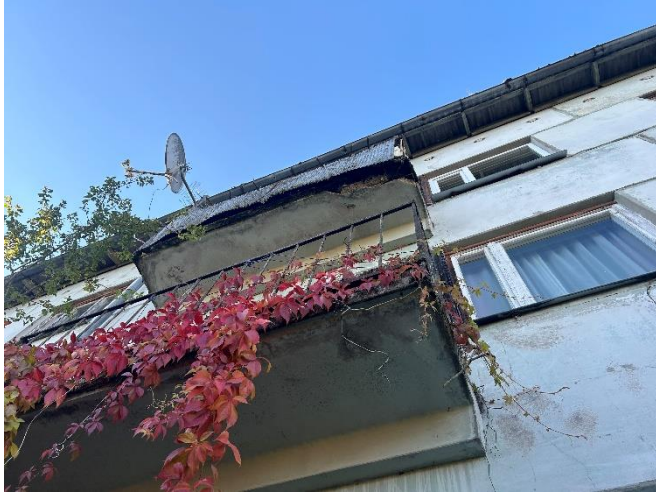
4.9.3. att. Vairāki balkoni pirmsavārijas stāvoklī ar būtiskiem nodrupumiem
