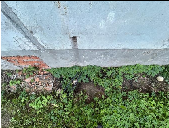
5.6.1. att. Kabeļi virs zemes
