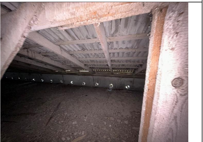
4.8.17. att. Bēniņu ventilācijas kanāli – aizbāzti ar ķieģeļiem (iespējams, lai nodrošinātos pret putnu iekļūšanu)
