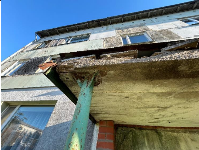
4.9.9. att. Mitruma radīti pleķi un ieejas jumtiņa dzelzsbetona konstrukcijas un iztrūkstošs koka nosegelements pa perimetru un korodējis metāla balsts
