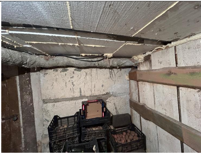
5.2.3. att. Oriģinālais siltumtrases siltinājums
