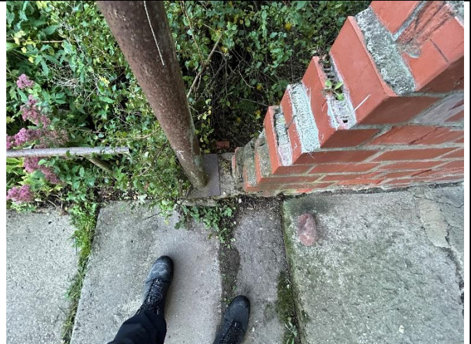
4.9.10. att. Korodējis ieejas jumtiņu metāla balsts un ieejas lieveņa grīda
