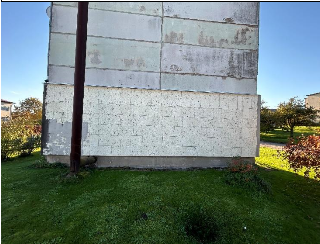
4.19.3. att. Siltumizolācija bez apdares
