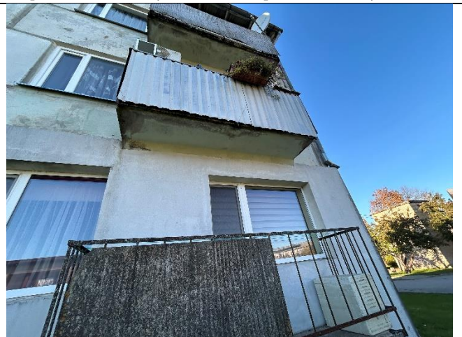
4.5.6. att. Lokāli siltināta ārējsiena pirmā stāva līmenī ar spraugām starp loksniem, atsevišķām loksniem nepietiekams dībeļu skaits
