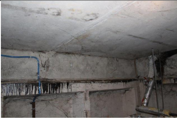
4.5.3. att. Pagraba daļa – horizontālā hidroizolācija
