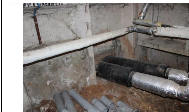
5.2.1. att. Siltumenerģijas aprītes caurules
