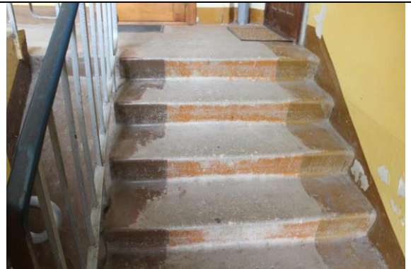
4.12.8. att. Betona klona grīdas segums kāpņu telpā
