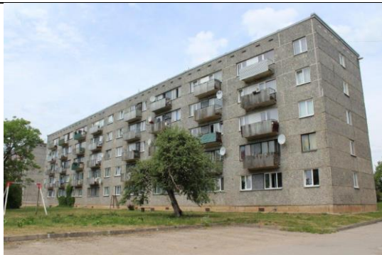
4.19.3. att. Ēkas dienvidu puses fasāde
