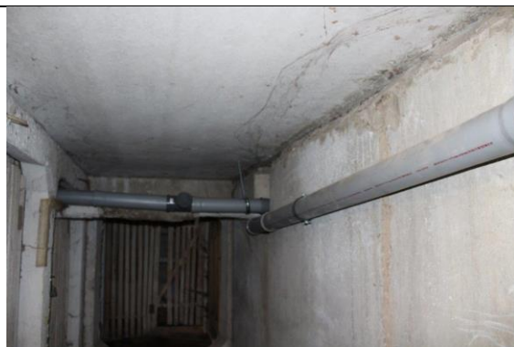
4.6.2. att. Pagrabstāva pārsegums - griesti
