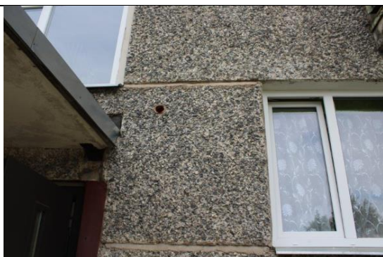
5.6.3. att. Ventilācijas atvērums dzīvoklī
