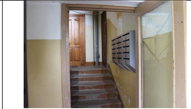
4.13.12. att. Koka konstrukcijas durvju aizpildījums vējtvertī
