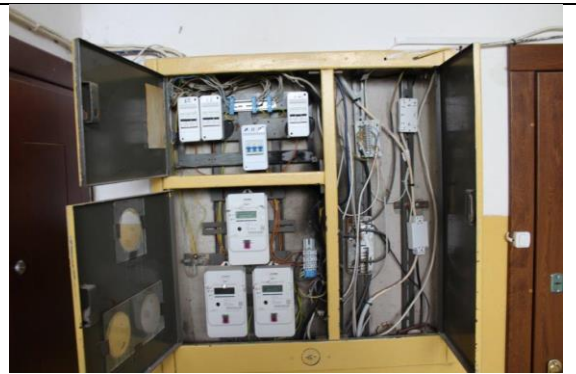
5.9.4. att. Komunikācijas sadalne kāpņu telpā
