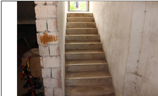
4.10.1. att. Betona konstrukcijas pagraba kāpnes
