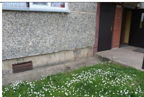
4.1.4. att. Pamatu virszemes daļa
