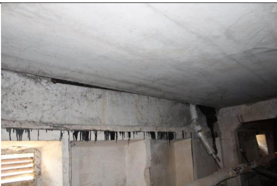
4.6.3. att. Pagrabstāva pārsegums - griesti
