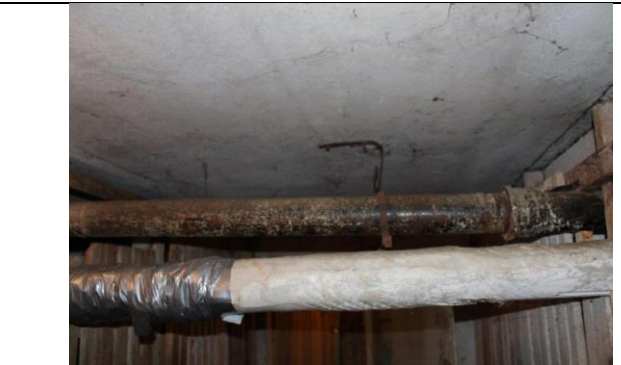
5.1.10. att. Kanalizācijas cauruļvadi
