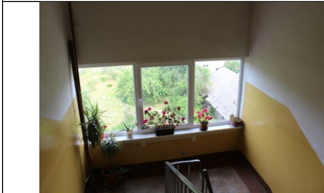
4.2.12. att. Nesošās konstrukcijas kāpņu telpā
