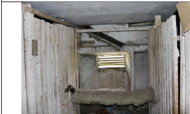
4.13.1. att. Pagraba ailas aizpildījums – ventilācijas reste
