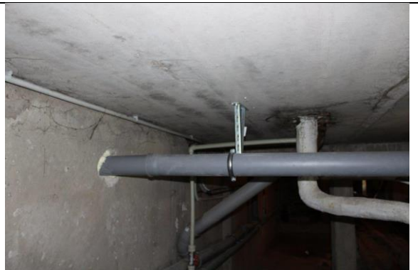
5.1.6. att. Kanalizācijas cauruļvadi
