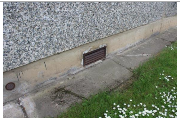
4.13.2. att. Pagraba ailas aizpildījums – ventilācijas reste
