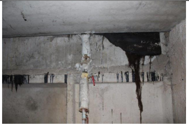
4.5.4. att. Pagraba daļa – horizontālā hidroizolācija
