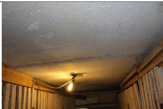
4.6.4. att. Pagrabstāva pārsegums - griesti
