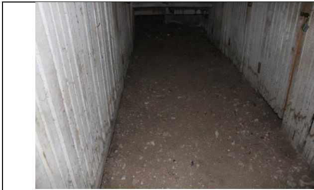
4.12.5. att. Pagrabstāvā grīda uz grunts
