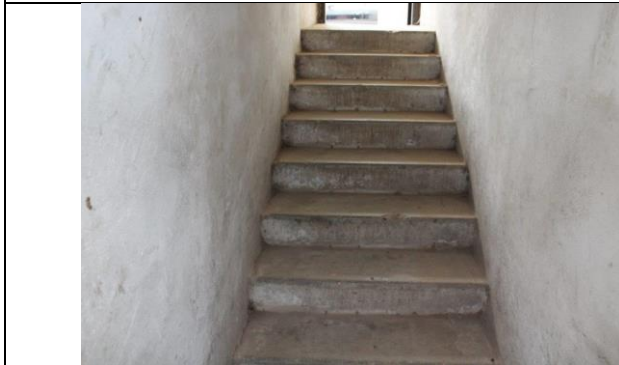
4.10.3. att. Betona konstrukcijas pagraba kāpnes
