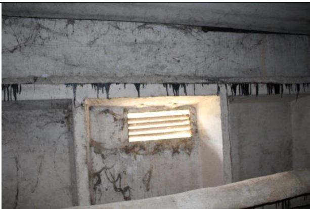
4.5.5. att. Aizdarīti pagraba logi ar ventilācijas resti
