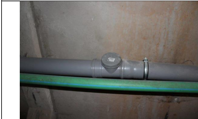
5.1.9. att. Aukstā ūdens aprītes un kanalizācijas cauruļvadi
