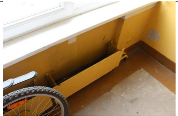
4.12.6. att. Betona klona grīdas segums kāpņu telpā
