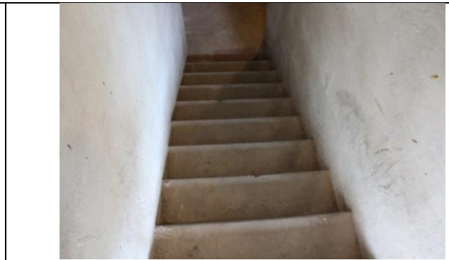
4.10.2. att. Betona konstrukcijas pagraba kāpnes
