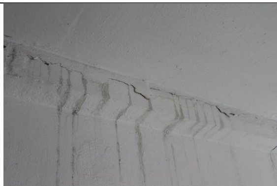
4.6.6. att. Bēniņu pārsegums – no kāpņu telpas puses
