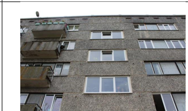
4.2.7. att. Ārsienu paneļu konstrukcijas
