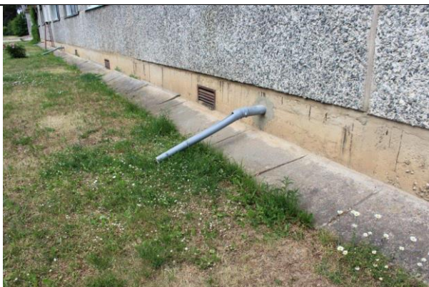
4.1.7. att. Pamatu virszemes daļa - betona aizsargapmale
