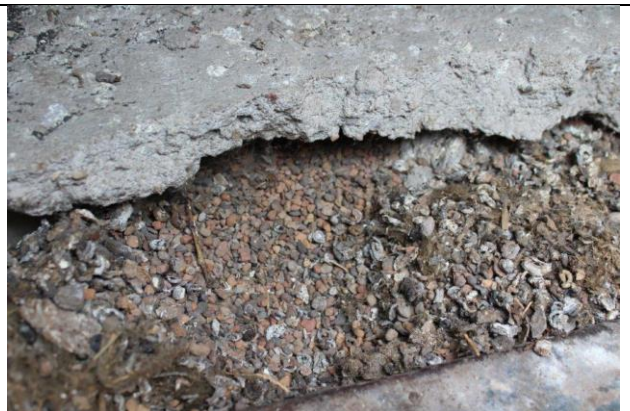
4.5.8. att. Bēniņu tehniskās telpas pārsegums
