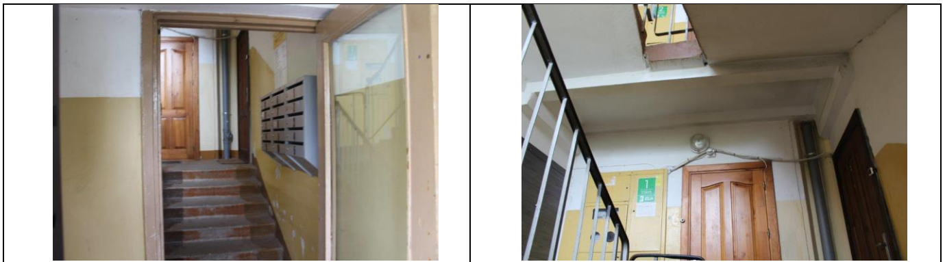
4.2.10. att. Nesošās konstrukcijas kāpņu telpā
