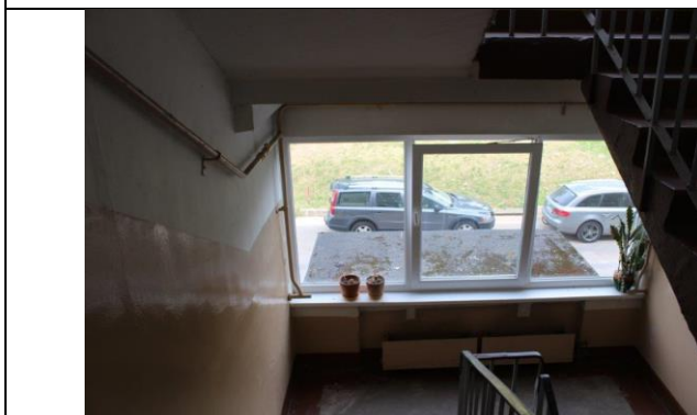
4.2.14. att. Nesošās konstrukcijas kāpņu telpā
