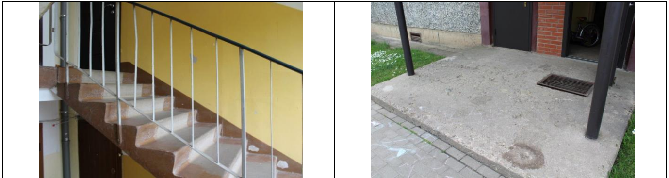
4.10.9. att. Betona konstrukcijas starpstāvu kāpnes, metāla margas
