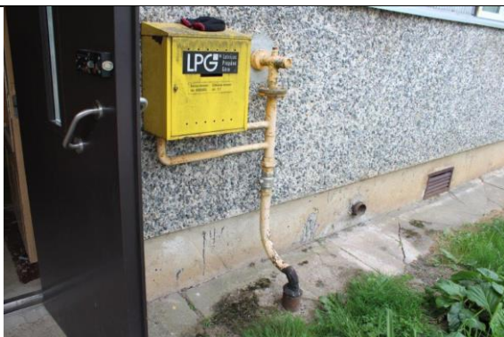
4.1.1. att. Pamatu virszemes daļa
