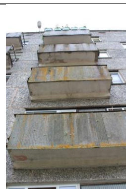
4.9.8. att. Ziemeļu puses balkoni
