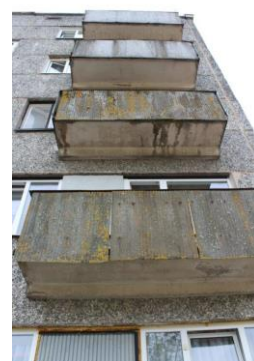
4.9.10. att. Ziemeļu puses balkoni
