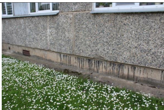
4.1.3. att. Pamatu virszemes daļa
