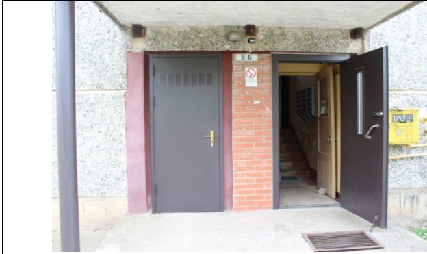
4.13.11. att. Metāla konstrukcijas durvju aizpildījums ieejas mezglā
