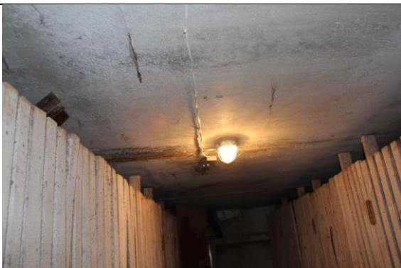
4.6.5. att. Pagrabstāva pārsegums - griesti
