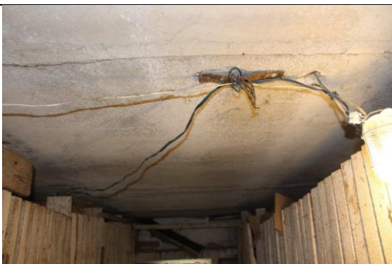
4.6.1. att. Pagrabstāva pārsegums - griesti
