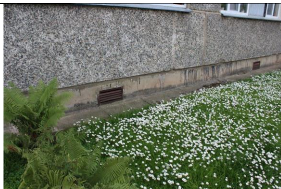
4.1.2. att. Pamatu virszemes daļa – betona aizsargapmale
