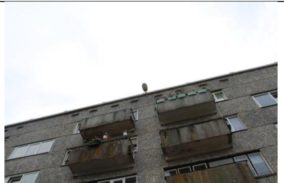
5.9.8. att. Elektroapgādes sistēmas elementi uz fasādes
