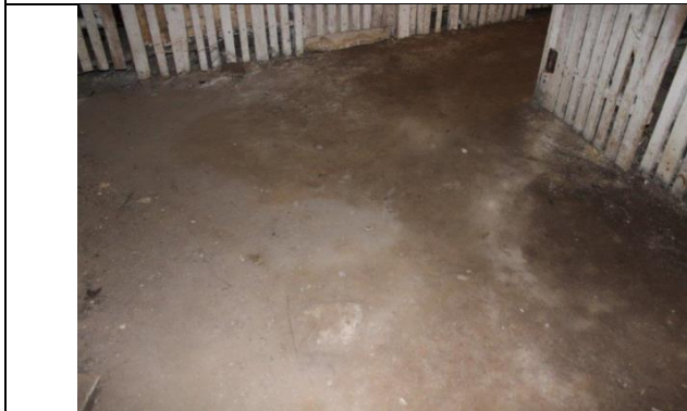
4.12.1. att. Pagrabstāvā grīda uz grunts
