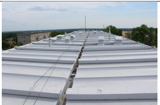
4.5.6. att. Jumta seguma hidroizolācija
