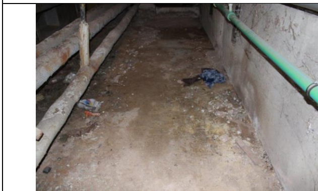
4.12.3. att. Pagrabstāvā grīda uz grunts
