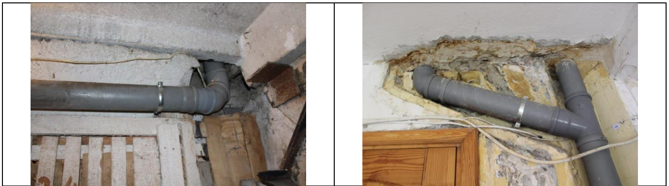
5.1.7. att. Kanalizācijas cauruļvadi
