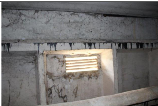
5.6.1. att. Pagraba aillas aizdarītas ar ventilācijas restēm
