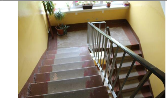
4.10.4. att. Betona konstrukcijas starpstāvu kāpnes
