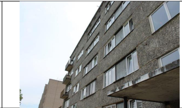
4.2.3. att. Ārsienu paneļu konstrukcijas
