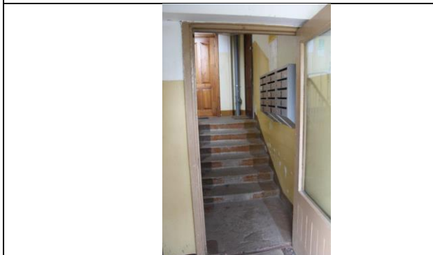
4.10.7. att. Betona konstrukcijas starpstāvu kāpnes
