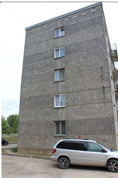
4.19.6. att. Ēkas rietumu puses fasāde
