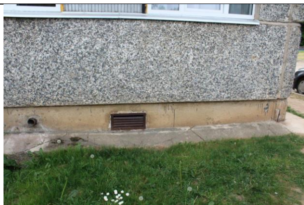
4.1.6. att. Pamatu virszemes daļa - betona aizsargapmale
