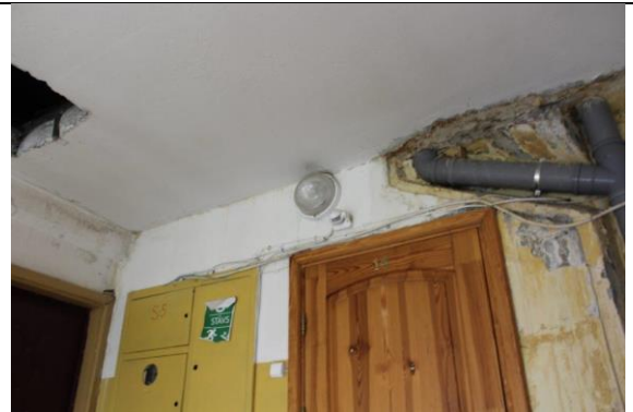
4.2.13. att. Nesošās konstrukcijas kāpņu telpā
