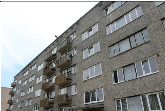
4.13.9. att. PVC konstrukcijas logu aizpildījumi dzīvokļos
