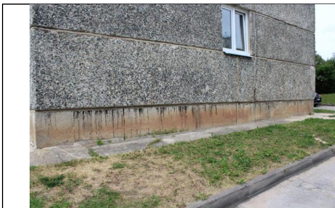
4.1.5. att. Pamatu virszemes daļa
