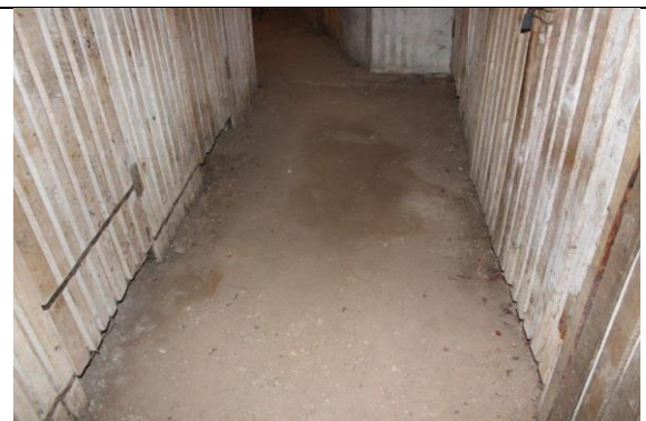
4.12.4. att. Pagrabstāvā grīda uz grunts
