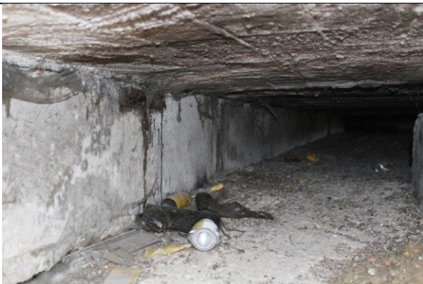
4.5.7. att. Bēniņu tehniskās telpas pārsegums
