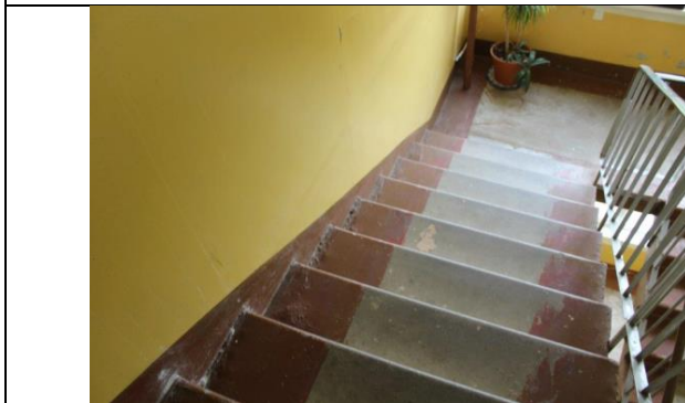
4.10.5. att. Betona konstrukcijas starpstāvu kāpnes
