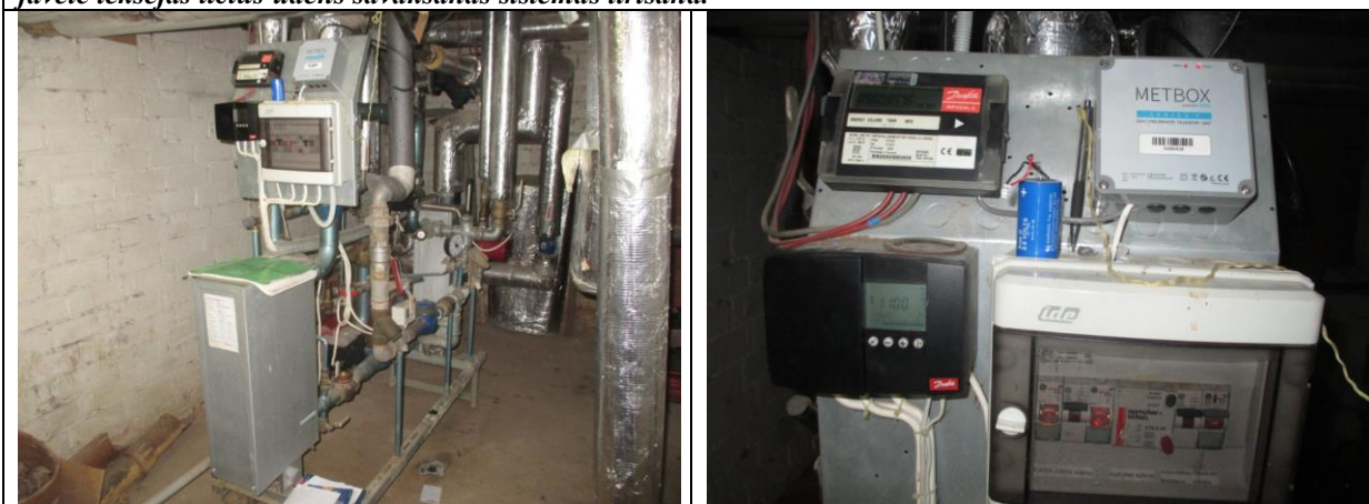
9. un 10. attēls. Ēkā uzstādīti divi automatizēti, neatkarīgā pieslēguma siltummezgli. Siltumenerģijas uzskaiti nodrošina divi siltumenerģijas skaitītāji.
