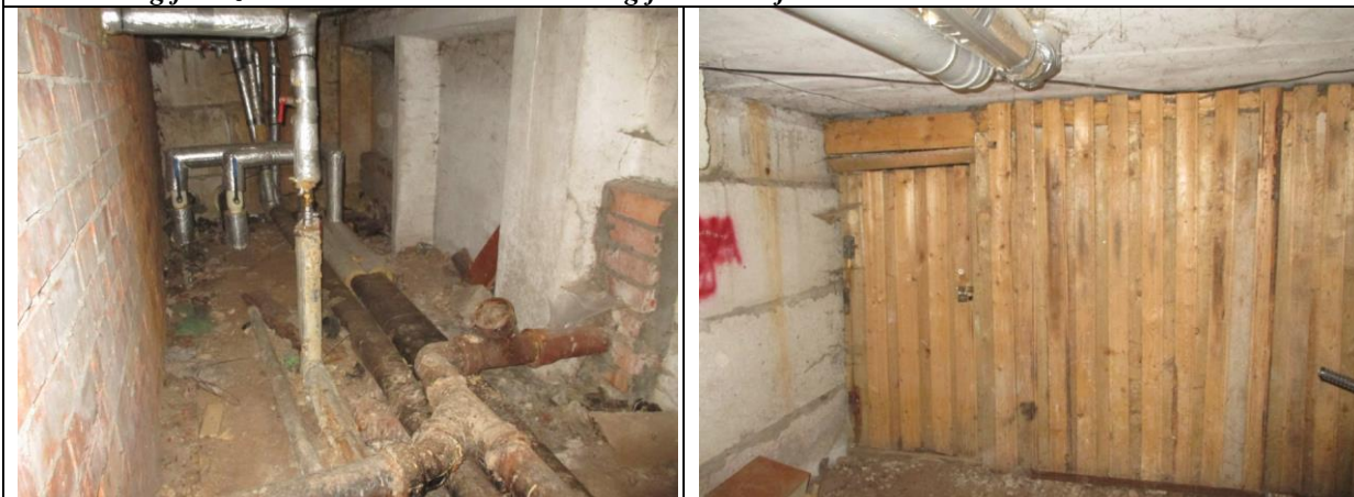
11. un 12. attēls. Ēkas pagrabstāva telpas. Veicot pagraba griestu siltināšanu, nepieciešams pievērst uzmanību dzelzsbetona pārseguma plaisu un koka šķūnīšu konstrukciju daļējai vai pilnīgai demontāžai, lai varētu kvalitatīvi veikt griestu siltumizolācijas uzklāšanas darbus. Kā arī jāsakārto pagraba grīdas segums, lai novērstu pastiprinātu gruntsūdeņu iesūkšanos pagraba telpās. Veicot ēkas atjaunošanu, ieteicama pagraba grīdas betonēšana.
