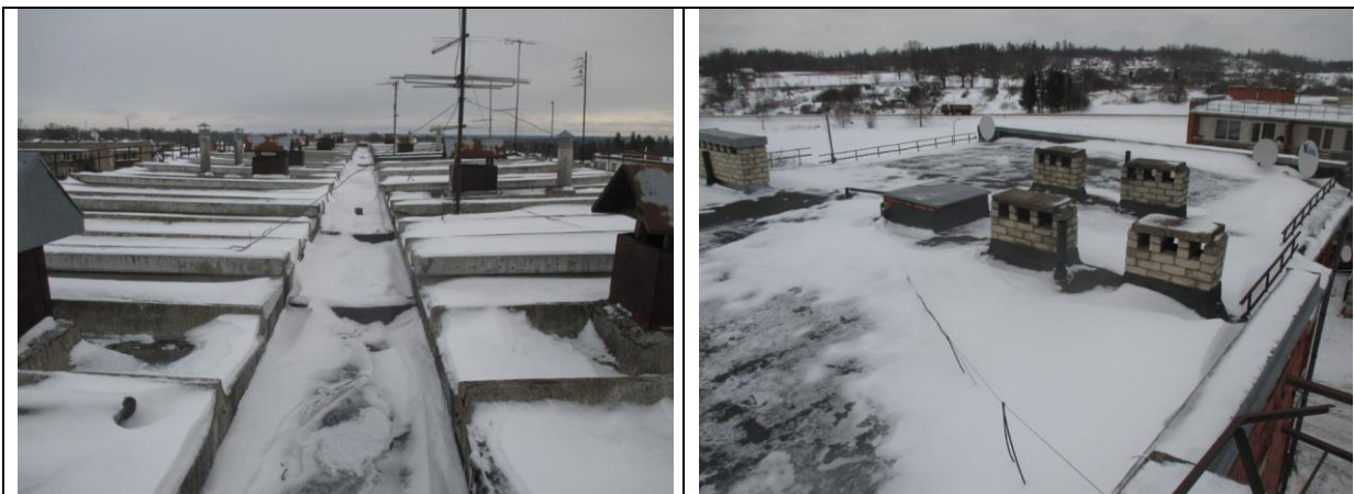
7. un 8. attēls. Ēkas augšējais pārsegums. Veicot jumta pārseguma atjaunošanu, ieteicams veikt dabīgās ventilācijas šahtu un jumtīņu atjaunošana, novēršot šo konstrukciju bojāšanos, laika apstākļu ietekmē, kā arī jāveic iekšējās lietus ūdens savākšanas sistēmas tīrīšana.
