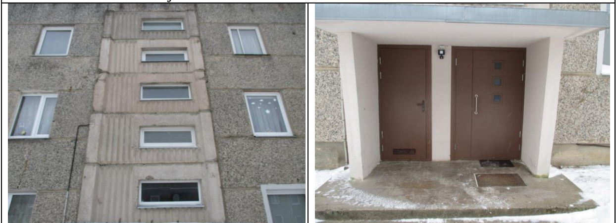
3. un 4. attēls. Kāpņu telpām uzstādītas siltinātas, metāla ārdurvis un PVC logi.
