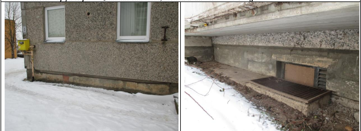
5. un 6. attēls. Ēkas cokola daļa un gaismas šahta zem balkona konstrukcijas.
