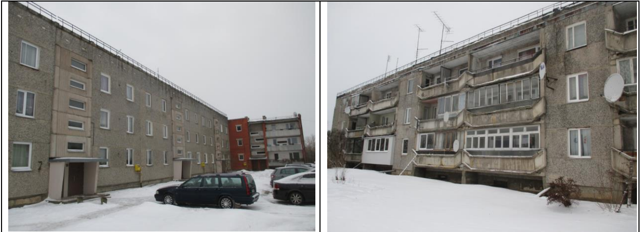
1. un 2. attēls. Ēkas ZA un D fasādes.
