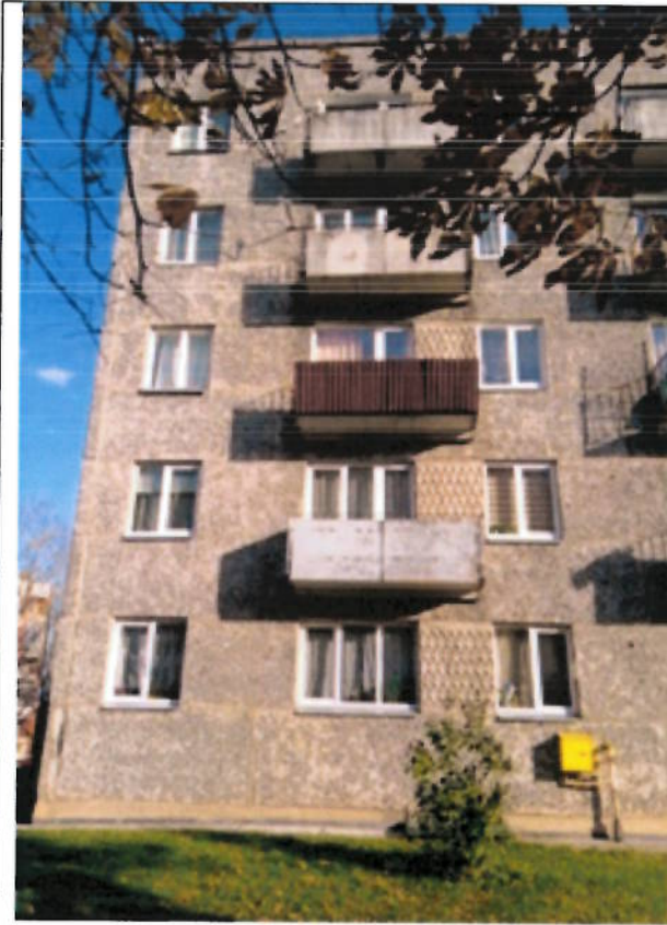
1. attēls – ēkas fasāde
